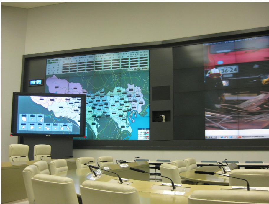
東京都防救災中心視訊設備-3
