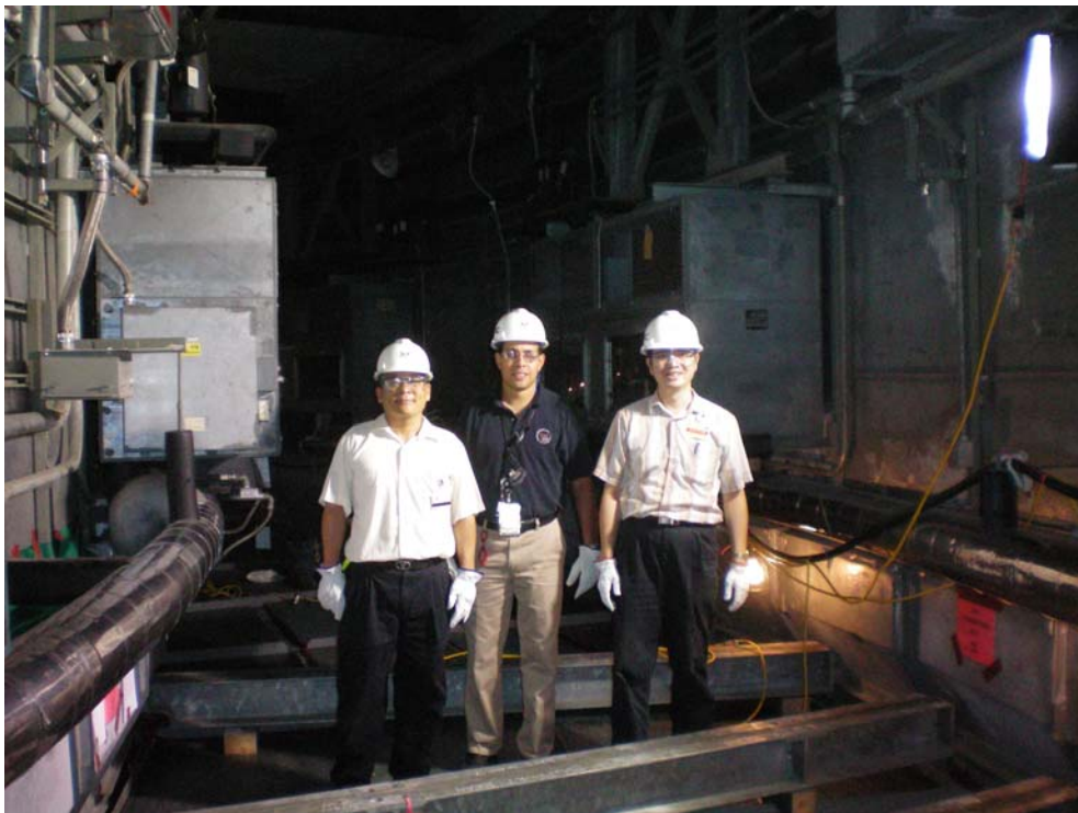
圖十 Watts Bar 電廠二號機安裝中的圍阻體 Ice Condenser (圖中為駐廠視察員 Tomy Nazario)
