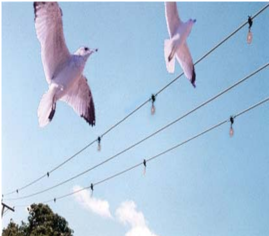
圖六、搖擺薄板之鳥類飛行轉向器(b)
