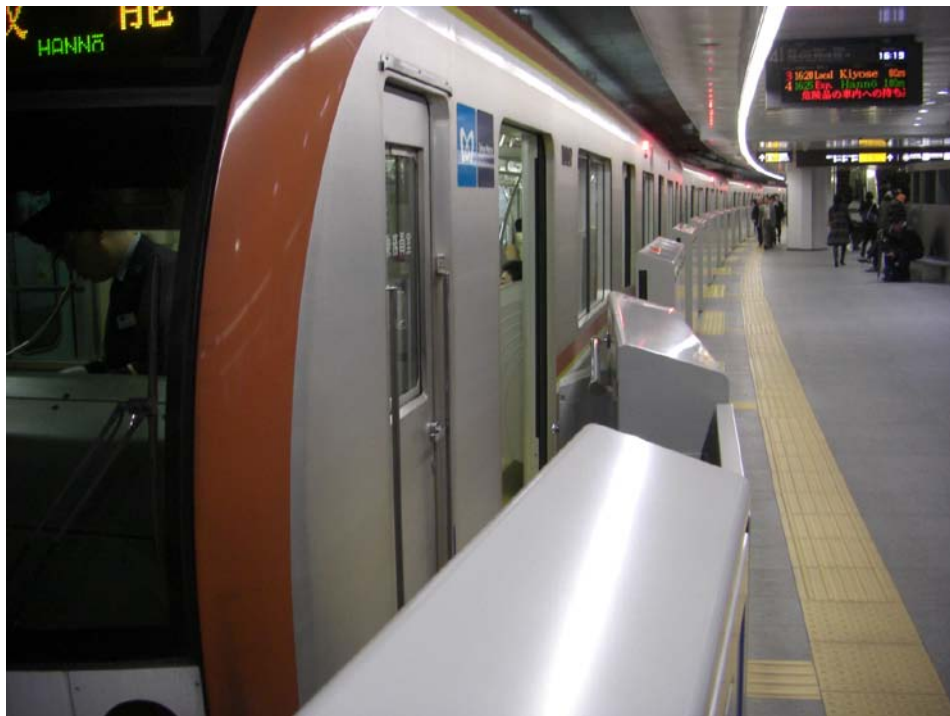
最後一組月台門採傾斜式安裝以利駕駛進出
