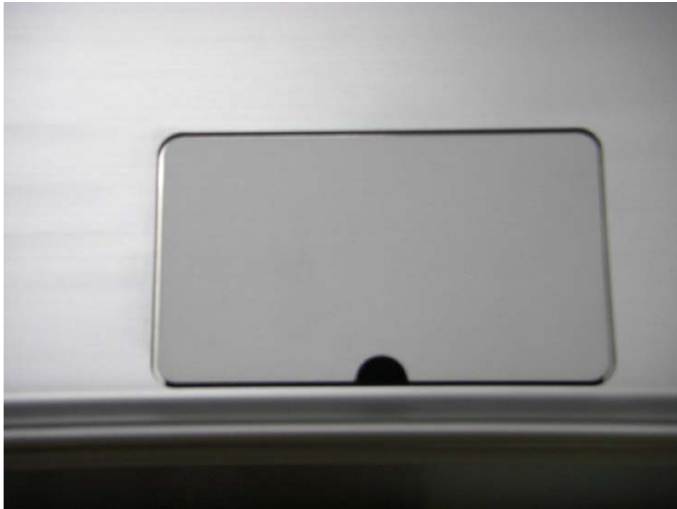
車內之車門緊急釋放裝置(因地鐵行經地下路段，不建議乘客自行操作，故無任何標誌說明)
