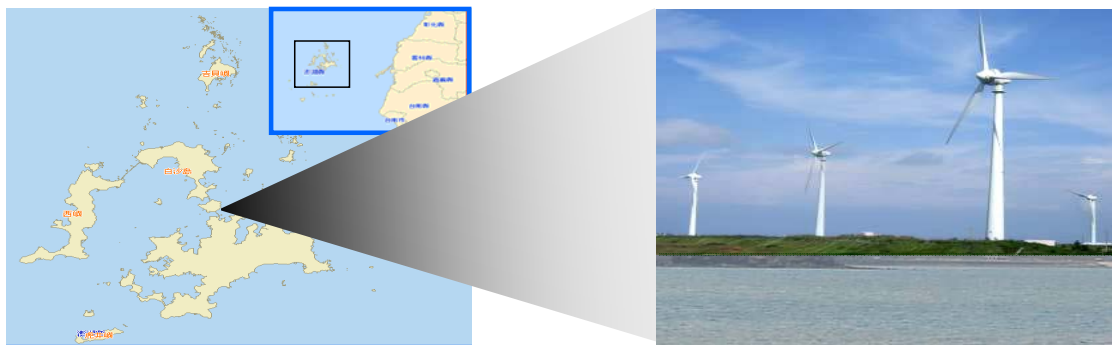
澎湖白沙島之中屯風電場: Enercon E40/600kW × 8
