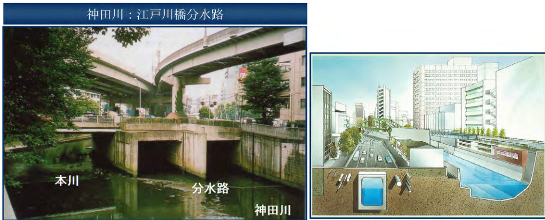
圖 2.14-6 神田川分水路建設
