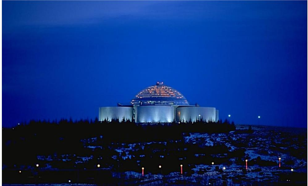
圖十七 雷克雅未克再生能源區域加熱系統的熱水儲槽與架構其上的旋轉景觀餐廳 Perlan 之夜景
