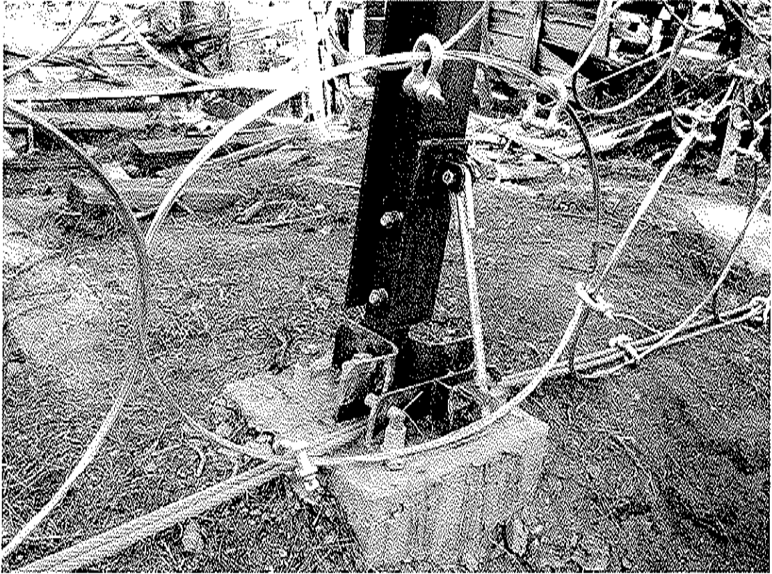
圖 6-19、消能網之骨架—鋼軌錨釘於地面
