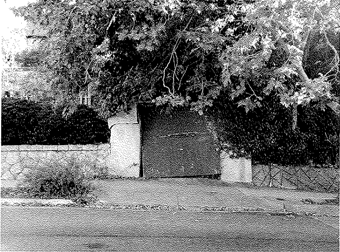
圖 4-1、克來山丘地滑造成的房屋裂縫
