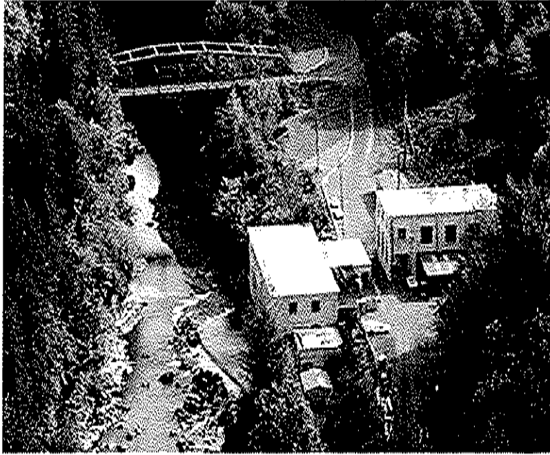
圖 5-12、Marmot 壩上游 Bull Run Powerhouse 發電場 ( http://www.portlandgeneral.com )
