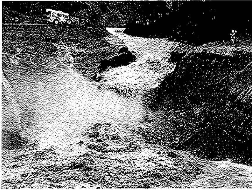
圖 5-19、以機具移除上游臨時性土壩 ( http://www.portlandgeneral.com )
