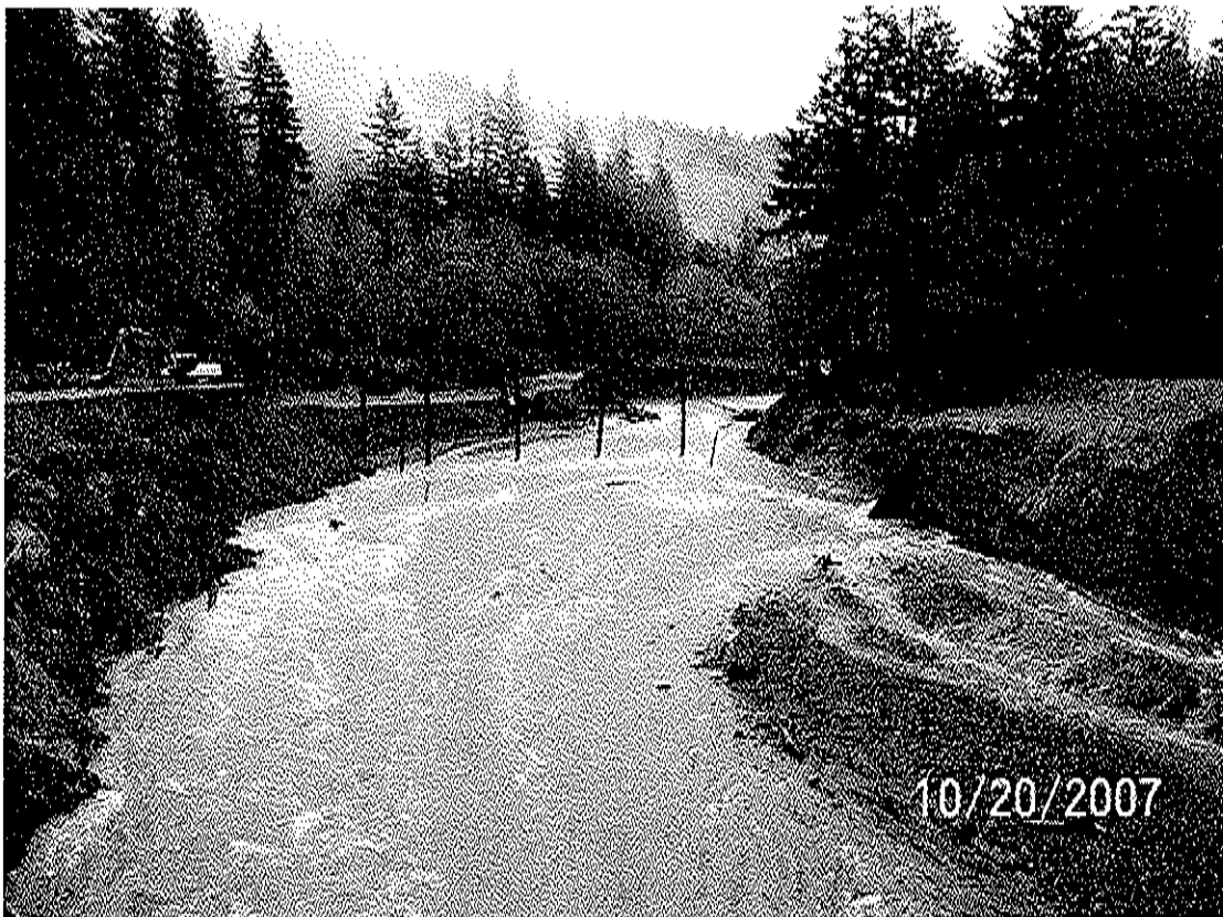
圖 5-20、Marmot dam 拆除後 (2007 年 10 月， http://www.fsl.orst.edu/wpg/ )
