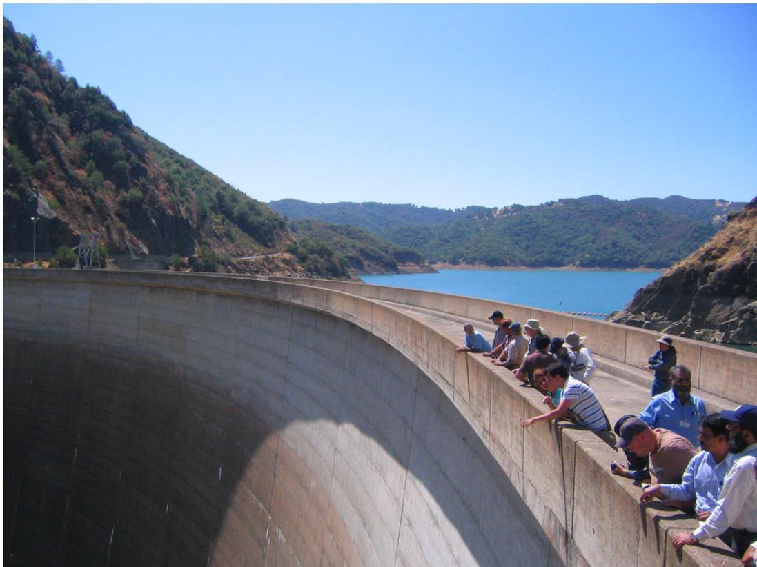
Monticello Dam 壩喇叭型溢洪道入口
