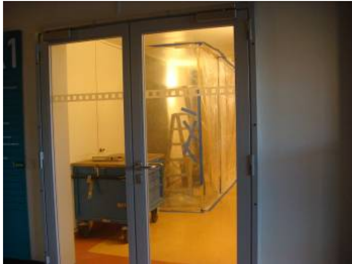
於日內瓦大學附設醫院拍攝內部整修時 預防工程產生的灰塵或瓦礫之設施
