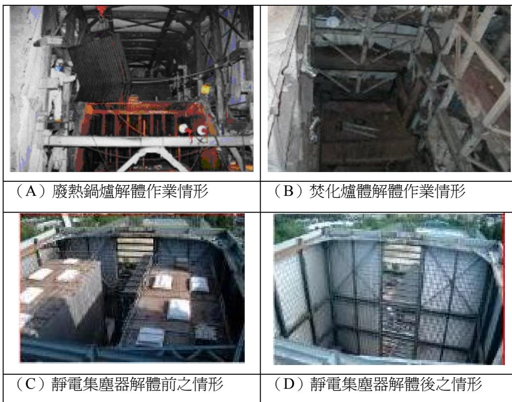
圖 6 設備解體工程作業情形
