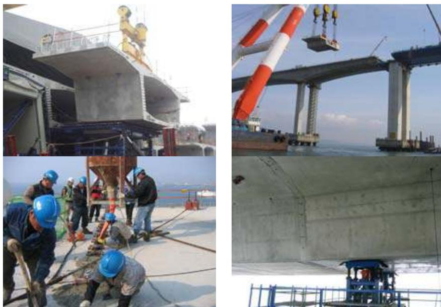
圖 2.13 接合處之預鑄吊裝及伸縮縫施工情形
