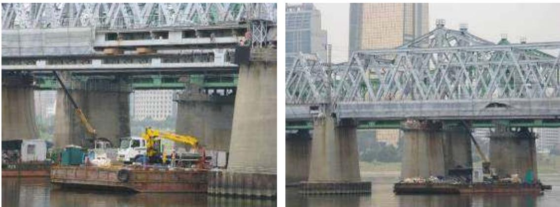
圖 2.23 跨河橋梁利用工作船進行橋體檢修
