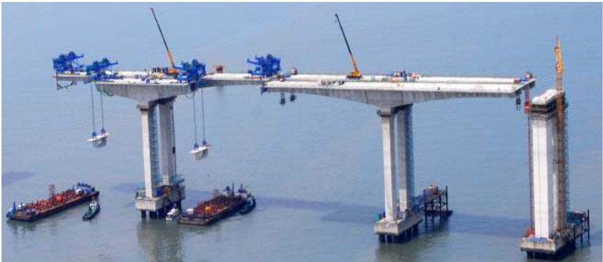
圖 2.12 平衡懸臂工法
