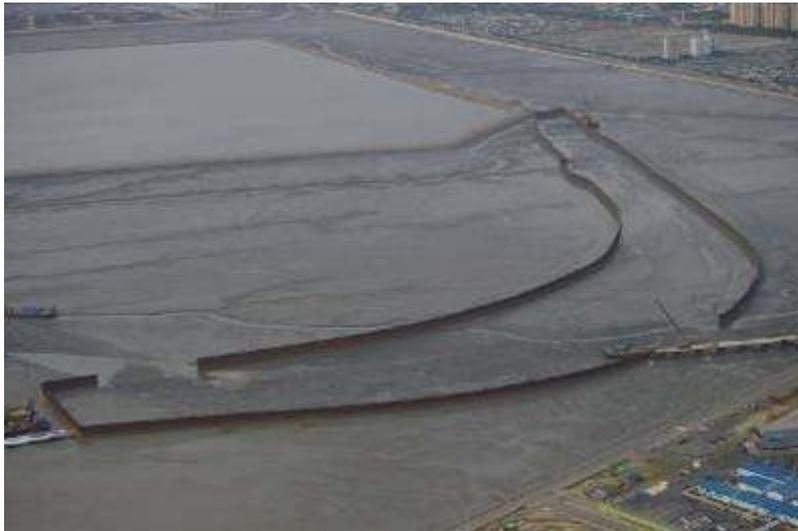
圖 2.8 圍堰施工
