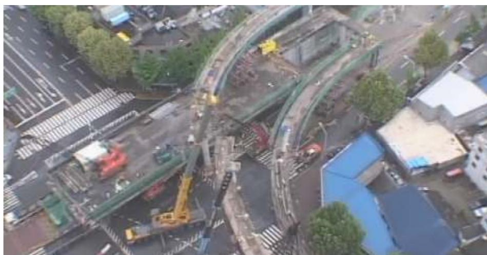
圖 2.27 位於清溪川覆蓋面上之橋梁拆除工程
