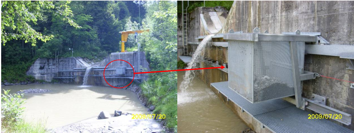
圖 14 2009 年新安裝的推移載收集籃
