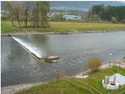
圖 33 Lienz/Iselsteg 試驗站現場狀況
