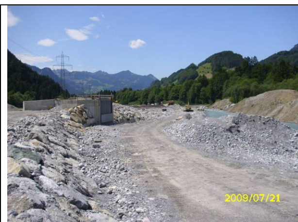
照片 28 Litz valley 水力電廠沉砂池
