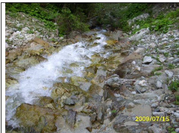
照片 11 Zaberbach 隱藏式河床穩定工法
