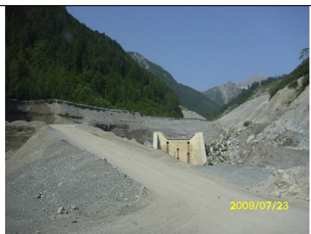
照片 40 Lech River 邊坡穩定整治工程(2)
