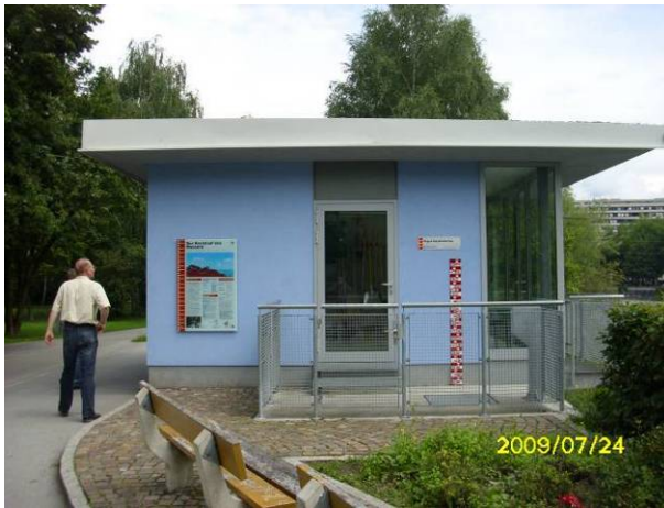
照片 49 Innsbruck-Inn 水文站外觀
