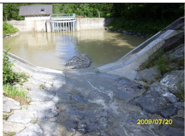
照片 24 Erlenbach 試驗站設備室及集砂池
