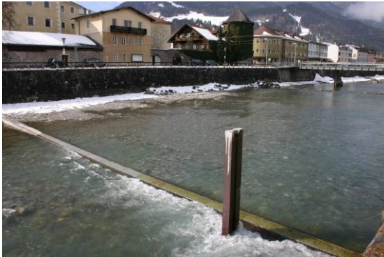
圖 29 Lienz/Iselsteg 試驗站現場狀況
