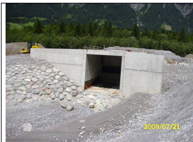
照片 27 Litz valley 水力電廠取水口
