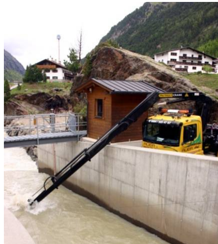
圖 25 吊車施作推移載取樣現場狀況
