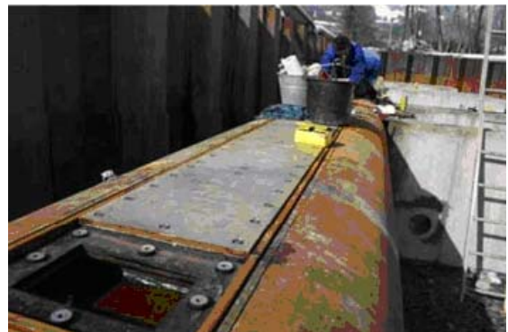
圖 40 感應鋼板安裝情形
