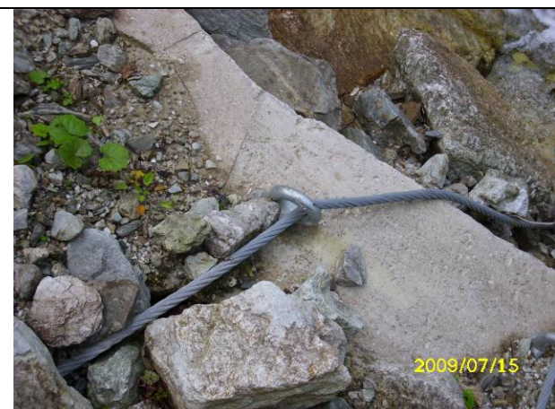
照片 12 隱藏式河床穩定工法之固定纜索
