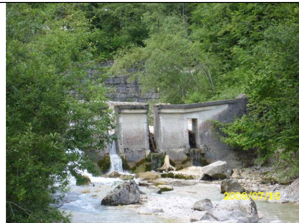
照片 17 Rubbach 系列防砂壩
