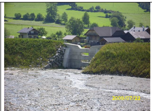
照片 36 Pustertal Valley 土石流整治工程(2)
