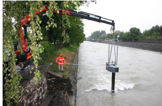
圖 30 TIWAG 推移載取樣器吊放作業
