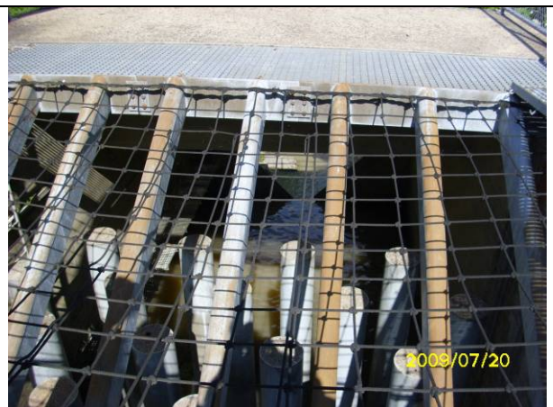
照片 26 Erlenbach 試驗站三角堰及堰前設施
