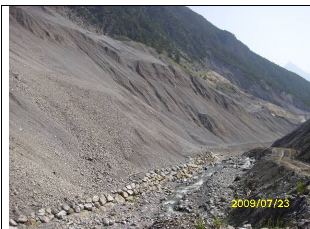
照片 39 Lech River 邊坡穩定整治工程(1)
