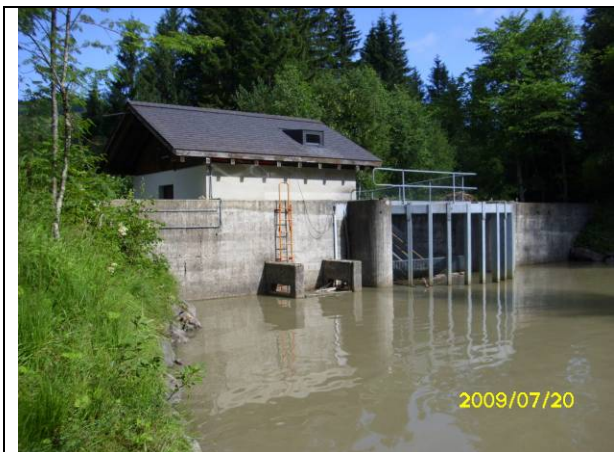
照片 25 Erlenbach 試驗站設備室
