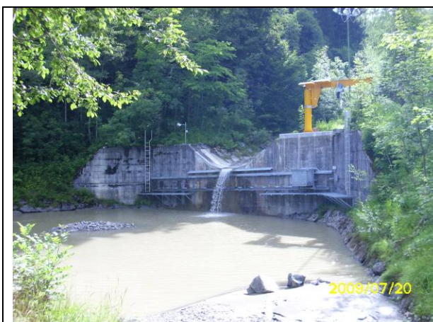
照片 23 Erlenbach 試驗站攔砂壩
