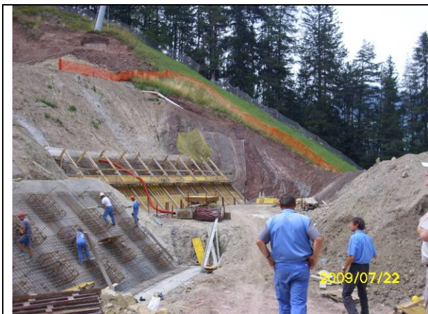
照片 37 Pustertal Valley 邊坡穩定工程
