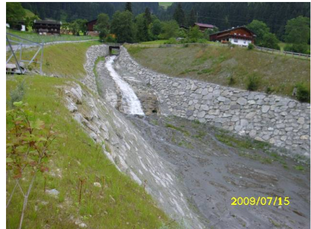
照片 10 Zaberbach 河道邊坡近自然工法
