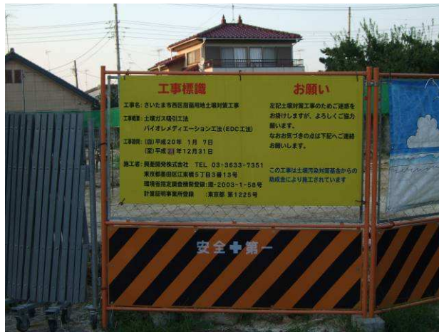
圖 20 場址工程告示看板
