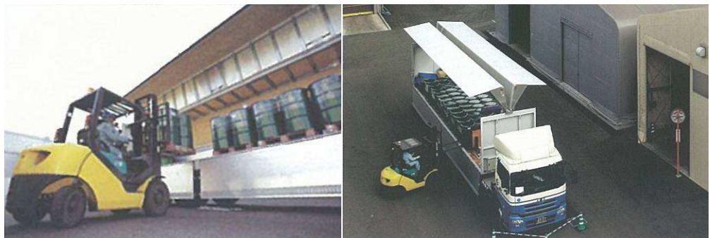
圖 7 離場土壤搬運至廠內情形 (GEOSTEAM 公司提供)
