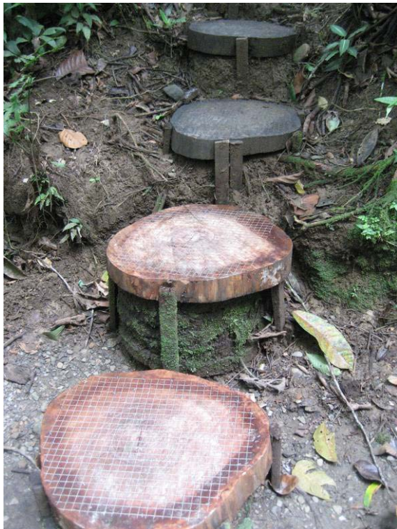
說明：園區步道以木頭包覆鐵絲網方式設計，具有止滑功能。
