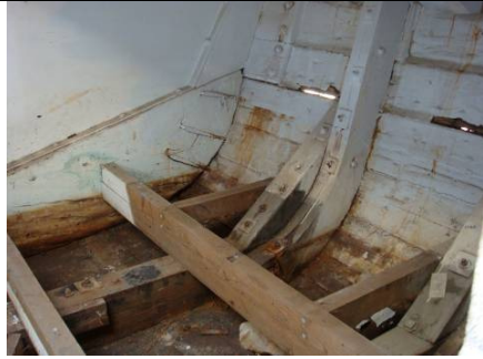
圖二十一、部分水密隔艙版被拆除，改用肋骨，以增加空間
