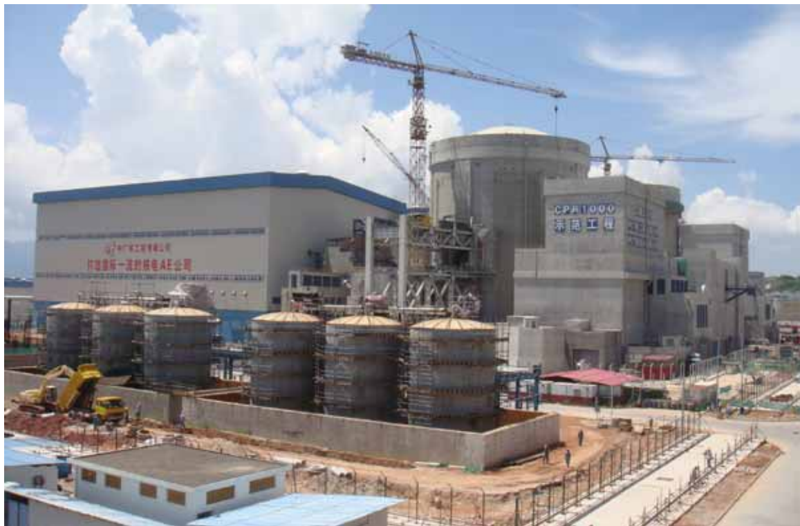
圖三-4 2009 年 8 月 18 日上午參觀嶺澳二期工程施工
