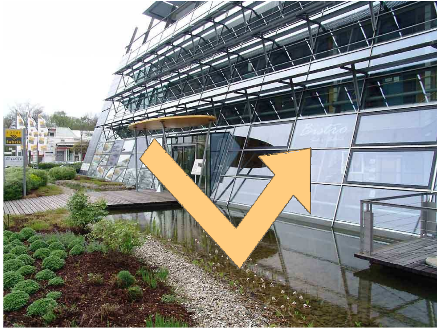
利用生態池冷卻進氣溫度
