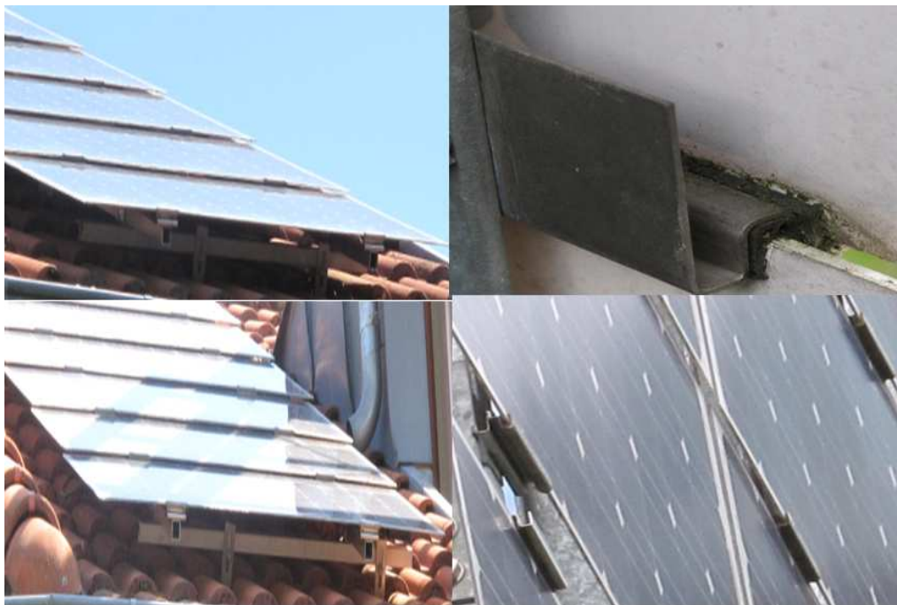
疊瓦片的固定方式(Profilink 固件)
