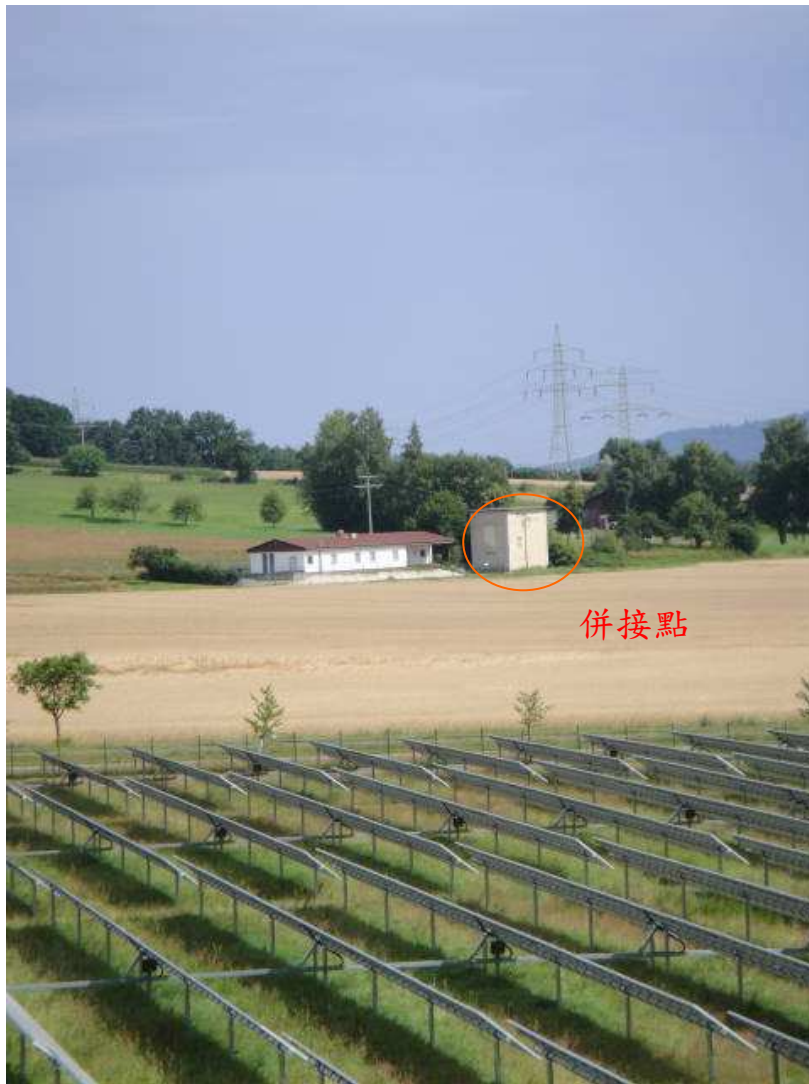
圖 2-3 電氣室經由地下管線，併聯到附近 22KV 輸電系統
