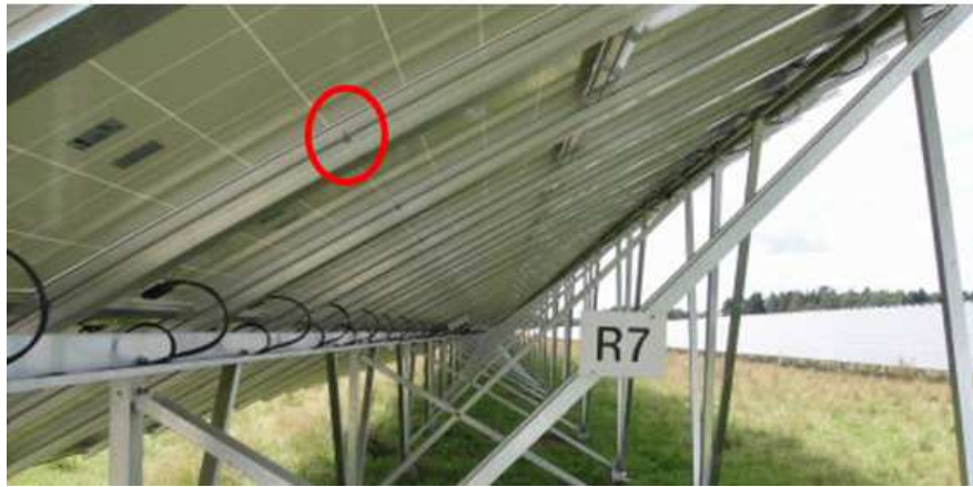
每片模組單側固定時須注意僅能固鎖一顆螺絲
