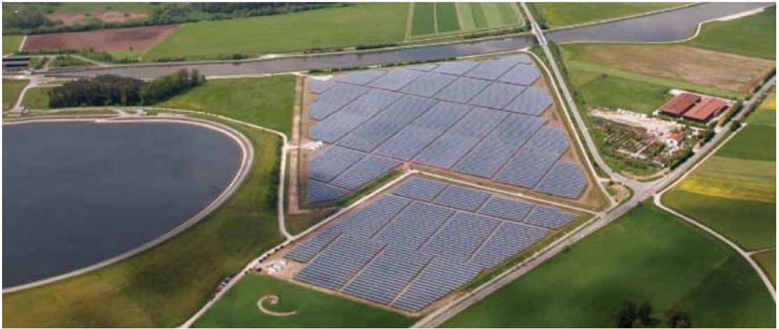
圖 2-1 Solarpark Muehlhausen 俯瞰圖
