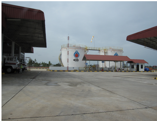
圖20-檢查PTT儲油槽
