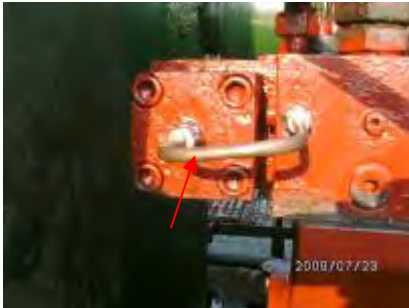
新製液壓管回裝完成
