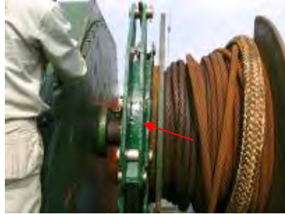
纜機剎車回裝完成
