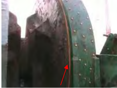
錨機剎車回裝完成
