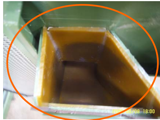
圖十四 金屬管道披覆橡皮膠質
