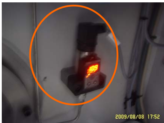
圖二十七 電控壓力開關
