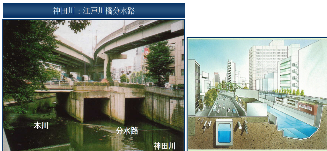
圖 3.13-6 神田川分水路建設
