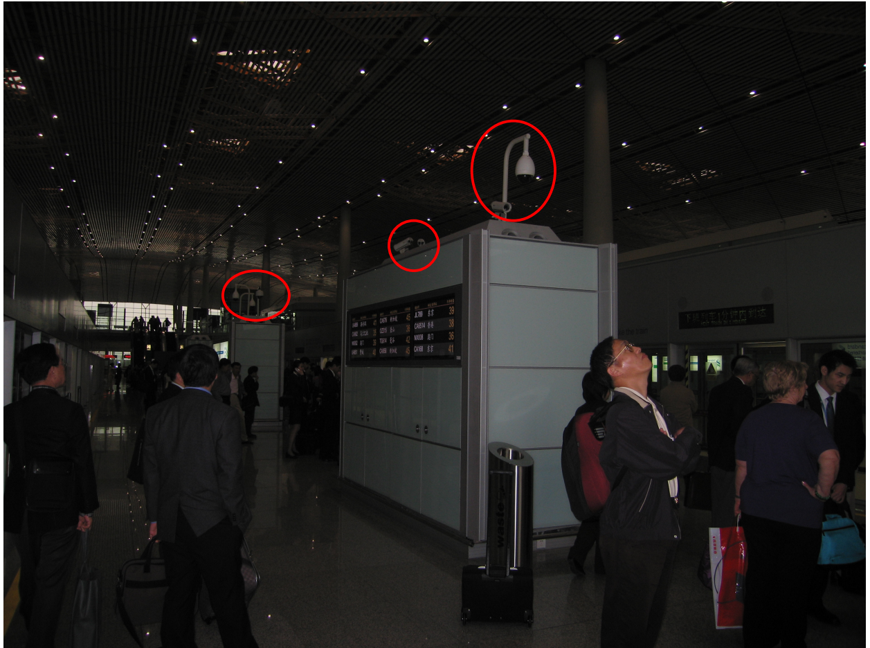
圖 3 首都機場 T3 入境管制區內攝影機分佈 (1/2)
