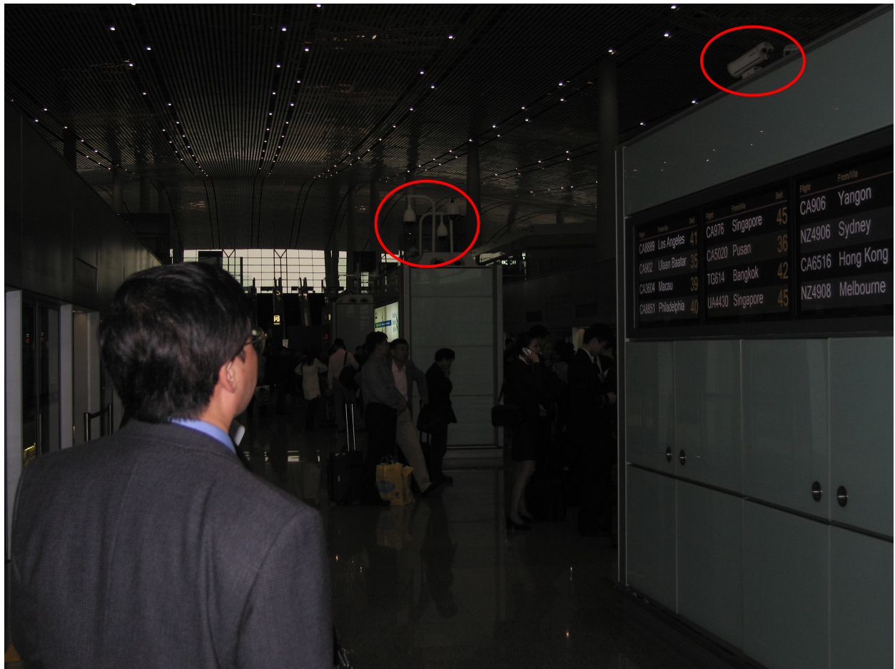
圖 4 首都機場 T3 入境管制區內攝影機分佈 (2/2)
