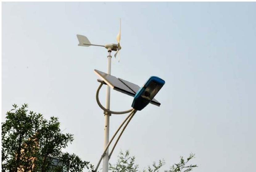
圖 21 綠色建築工程研究中心辦公樓中太陽能及風能路燈
