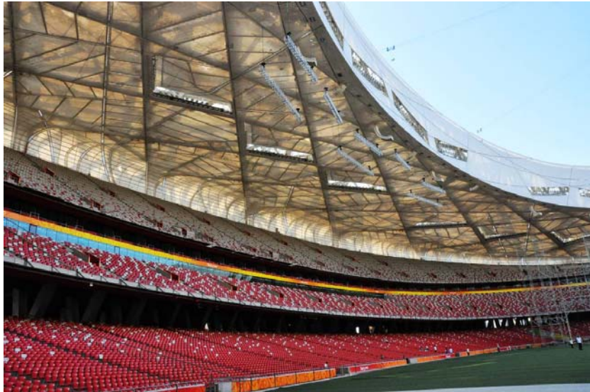
圖 4 鳥巢體育館 ETFE 及 PTFE 屋頂薄膜
