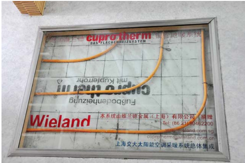
圖 20 綠色建築工程研究中心辦公樓太陽能地板採暖系統
