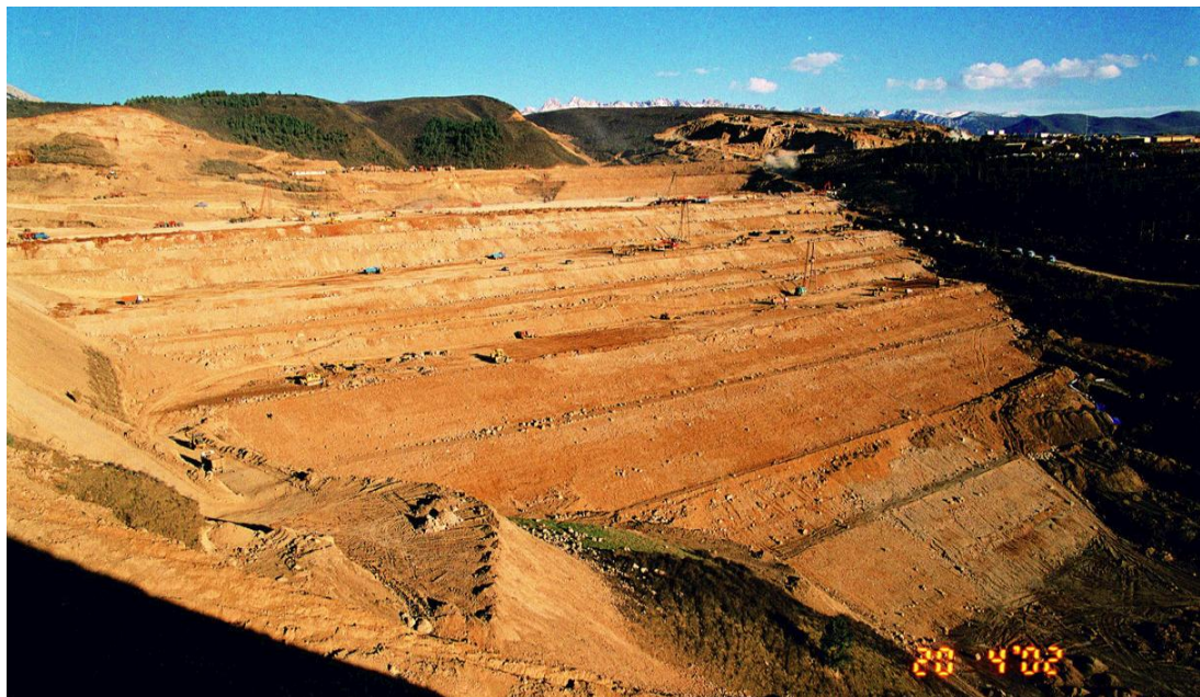
圖二 機場挖填工程
