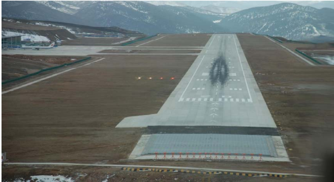
圖五 安裝 EMAS 後之 20 端跑道
