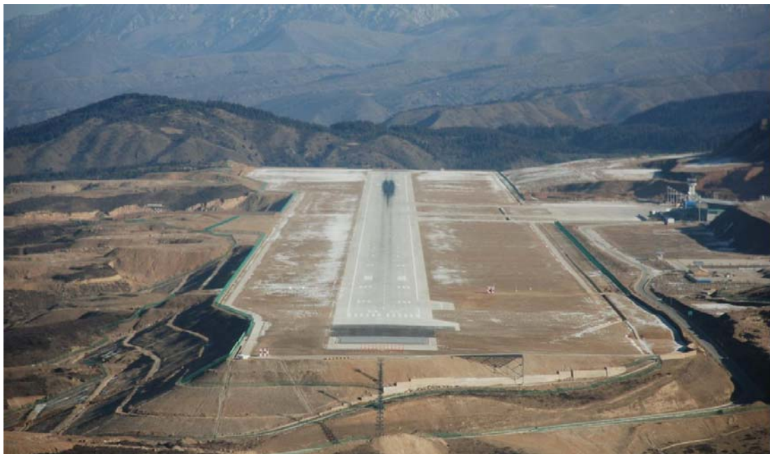
圖六 安裝 EMAS 後之 02 端跑道
