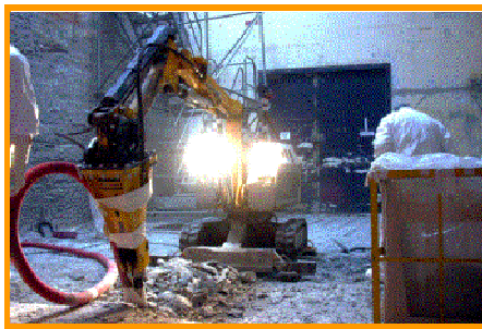
圖 33. 遙控操作震動破碎機評估範例
