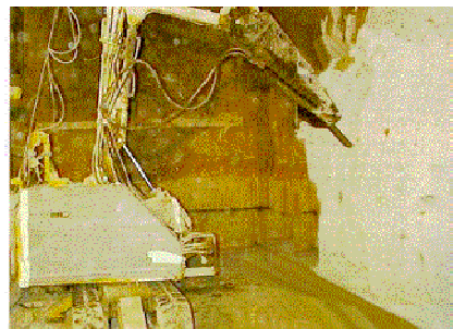
圖 33. 遙控操作震動破碎機評估範例
