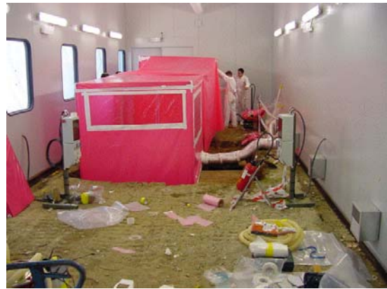
圖 24. 包封房間內污染土壤取樣工作情形
