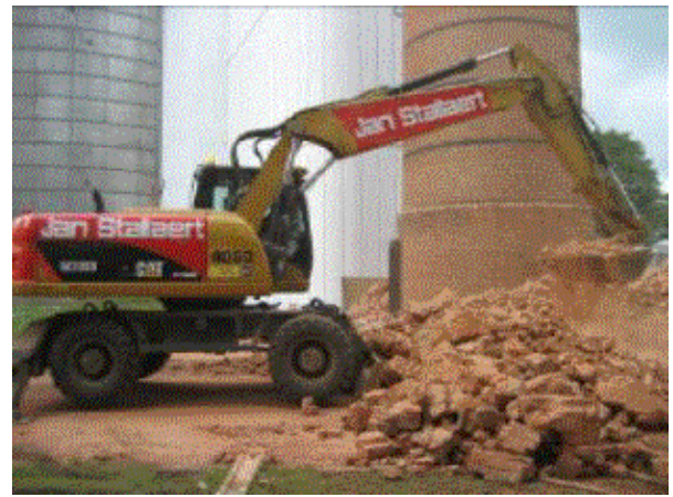
圖 9. 比利時 BR3 煙囪拆解施工情形(2)
