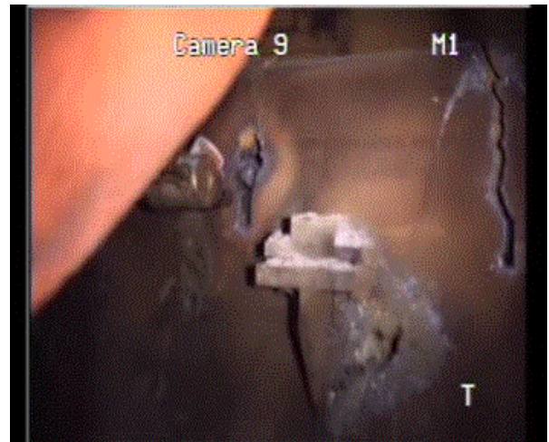
圖 4. 英國 WAGR RPV 水平切割情形
