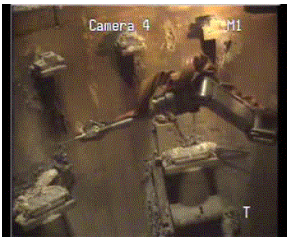
圖 3. 英國 WAGR RPV 垂直切割情形
