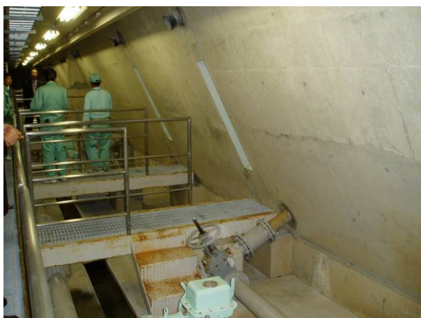
(c)沉澱池污泥坑內部
