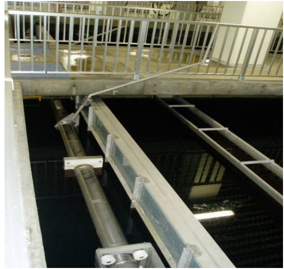
圖 13 沈澱池浮渣手動去除裝置
