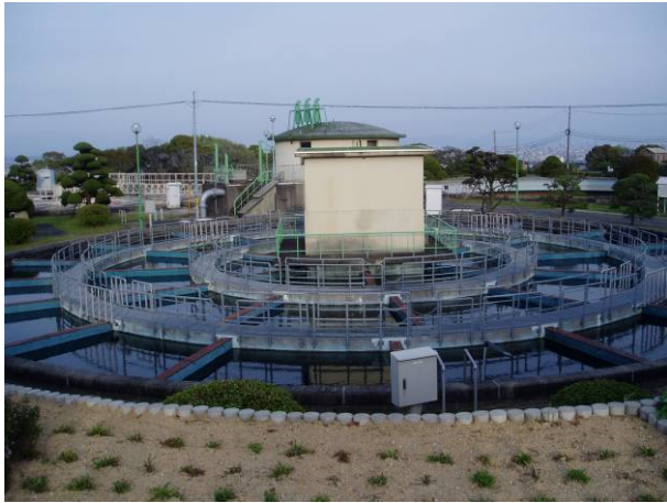
(k)高膠羽沉澱池
