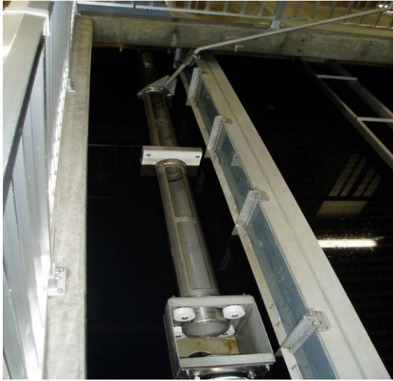
圖 13 沈澱池浮渣手動去除裝置
