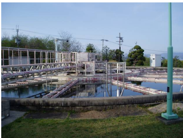
(i) 高膠羽沉澱池
