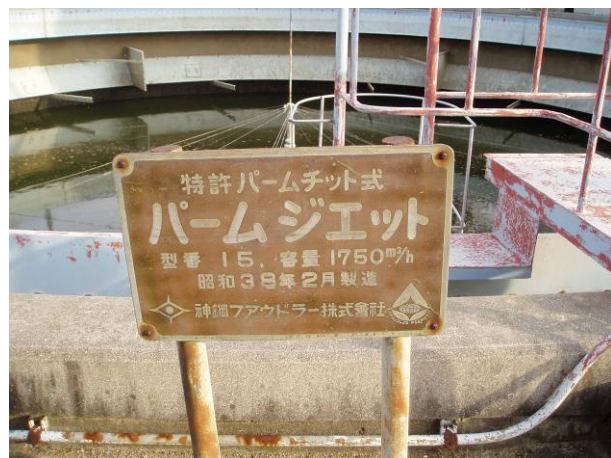
(j) 高膠羽沉澱池
