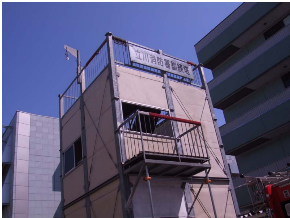
相片 12：立川消防署訓練塔
