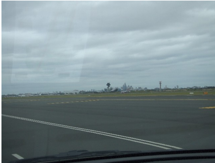
寬大之滑行道道肩（繪設有黃色道肩橫向標線）及其側邊勤務道路。
