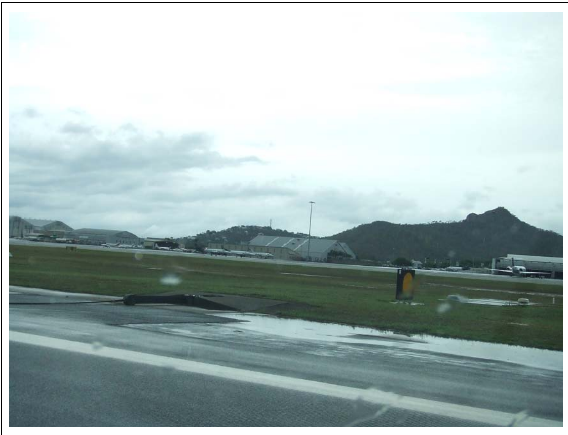
圖 11 湯斯維爾機場攔截索設施
