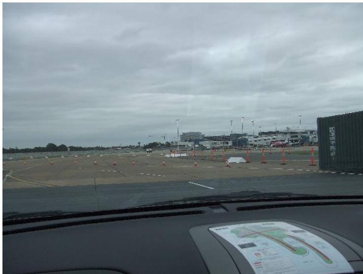
07 跑道端 之 RESA 工程阻絕設施。
