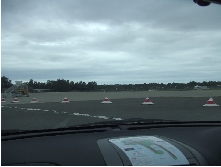
雪梨機場施工組絕設施。
