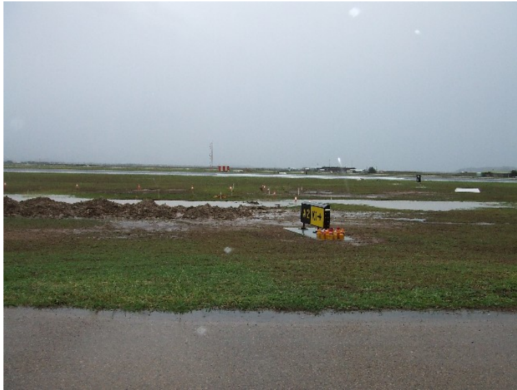
滑行道地帶施工區。
