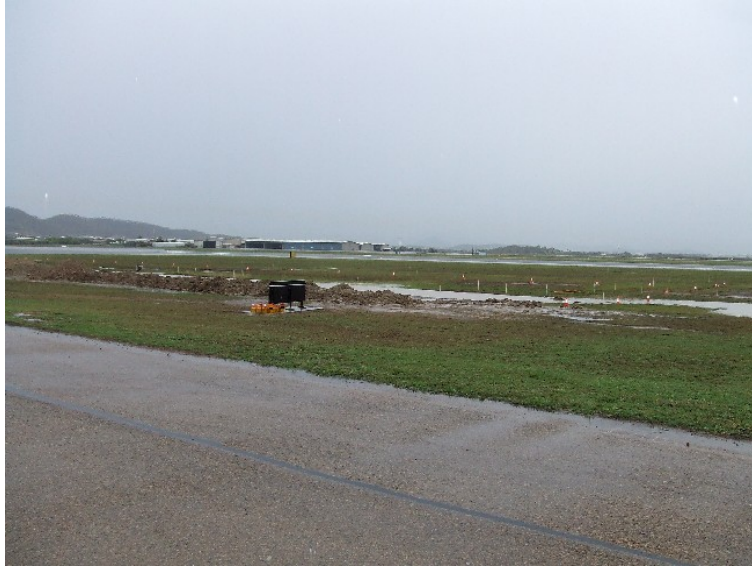
滑行道地帶施工區。
