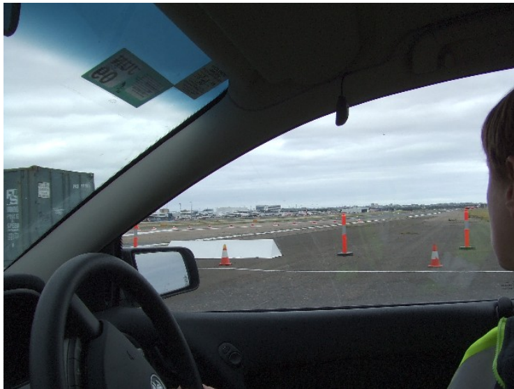
07 跑道端之 RESA 工程阻絕設施。
