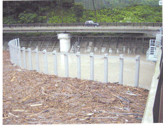
圖 2-74 排砂隧道入水口前的攔木柵
