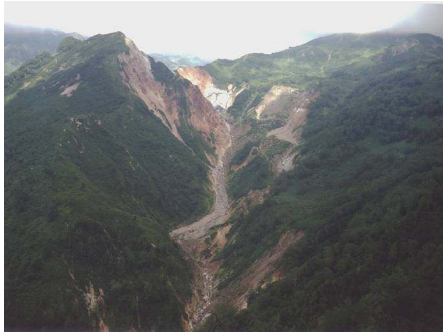
圖 2-4 黑部川上游山坡地崩塌
