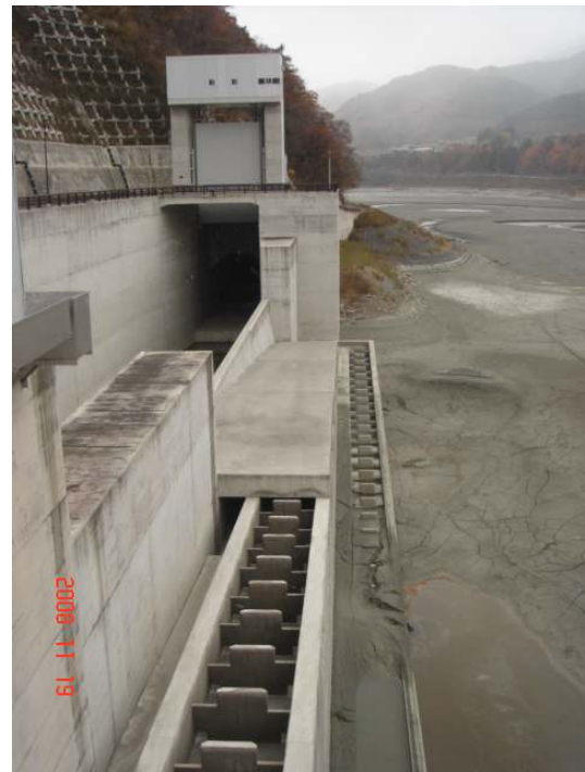
圖 2-70 繞庫排砂隧道入口
