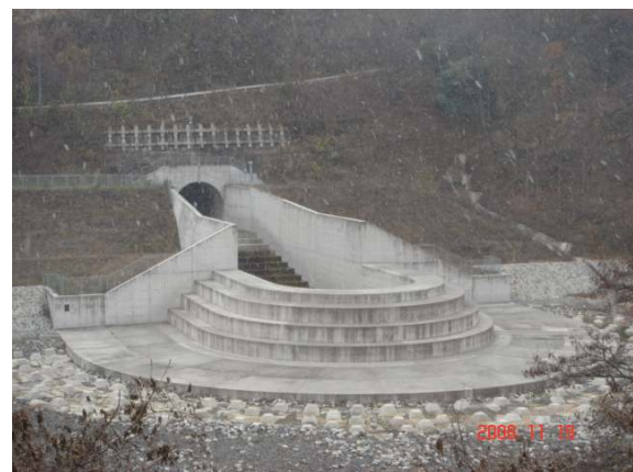
圖 2-72 繞庫排砂隧道出口
