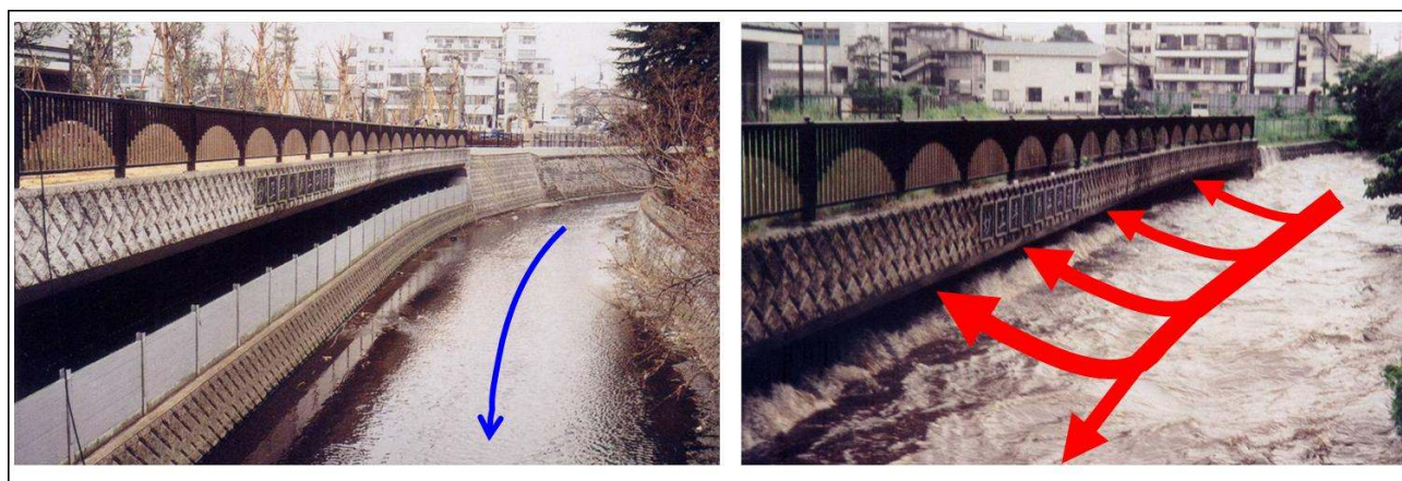
圖 2-78 洪水流入調節池實例(左：平常時，右：洪水時)
