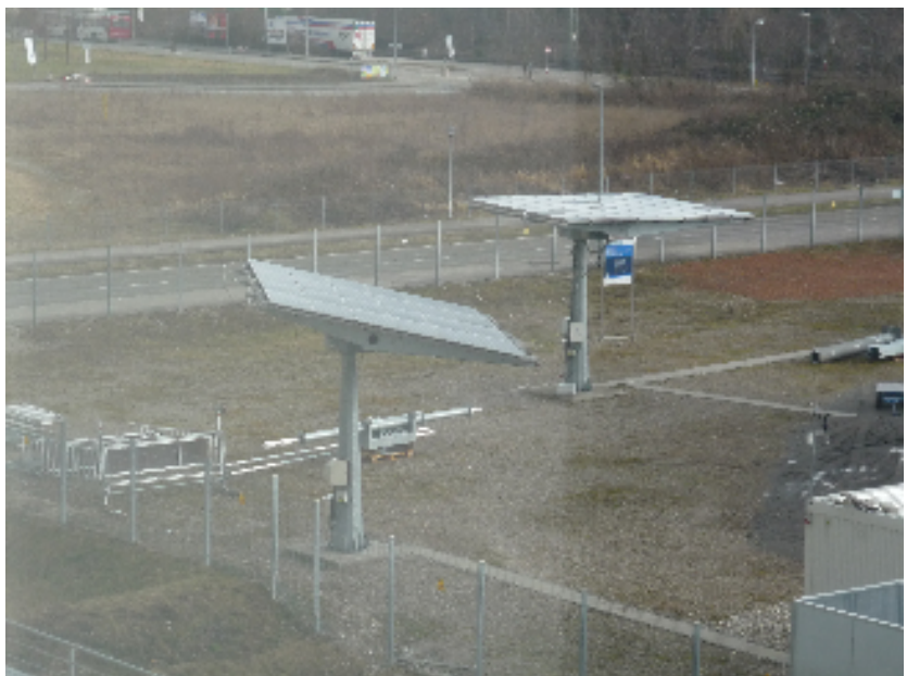
圖 8、單支撐桿式雙軸齒輪帶動追蹤器平台
