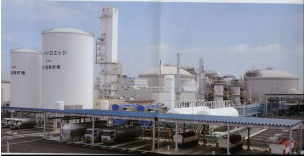
圖 3 HYDRO EDGE 公司之工廠外觀
