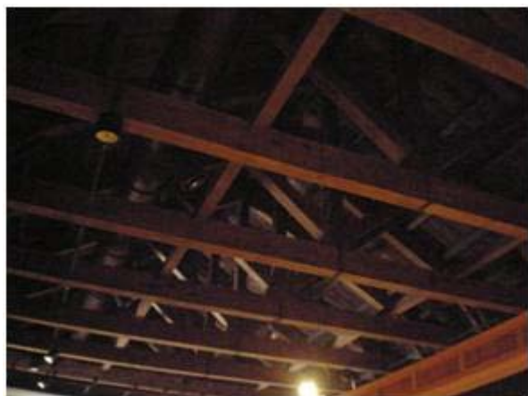
圖 3-39:鐵道科學歷史館木構屋頂
