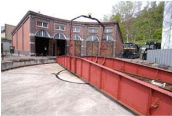
圖 3-3:機關車庫和轉車台
