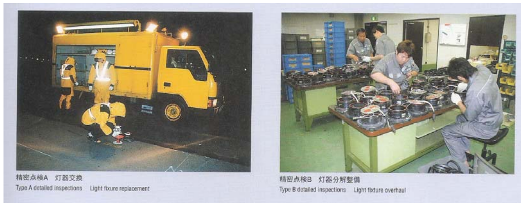
圖 3.3.16 更換場面故障燈光的情形及故障燈具維修情形
