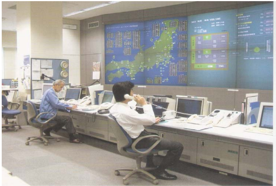
システム統制監視画面を見ながら調整するシステム統制官
