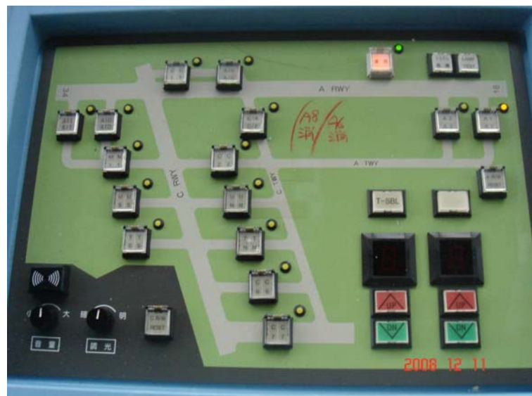
圖 3.3.12 東京成田機場的停止線燈系統
