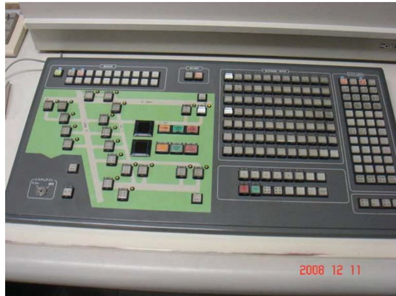
圖 3.3.14 燈光維護監控中心燈光系統與停止線燈系統操作工作檯。
