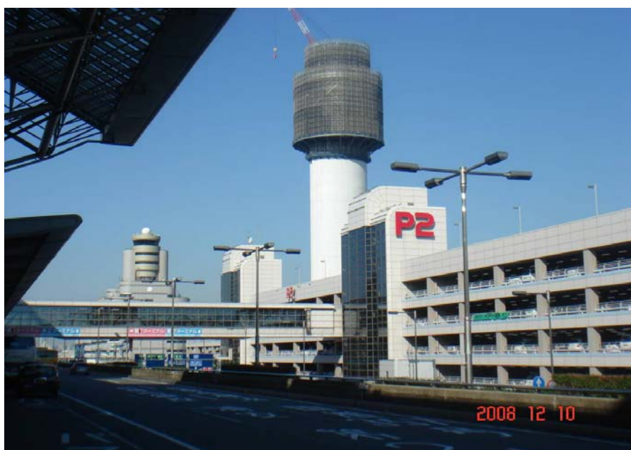
圖 3.2.1 東京羽田機場正在建造中的新塔臺
