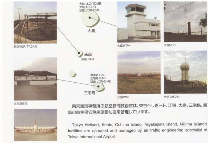
圖 3.2.5 外島助導航設備
