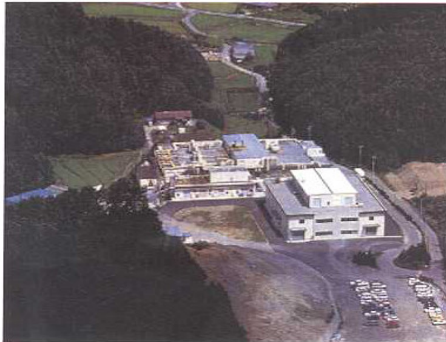
圖十二、SLC 引佐支所（Inasa production facility）
