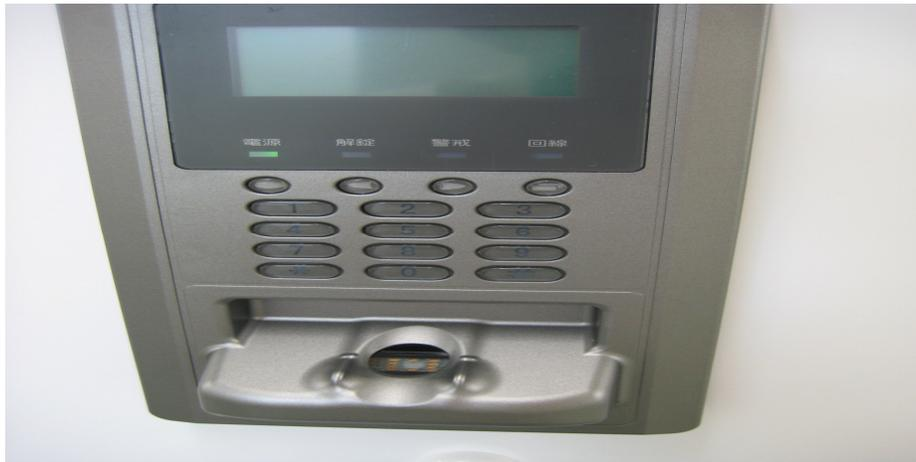
圖十一：村山分室流感管控中心大樓指紋辨識磁卡系統
