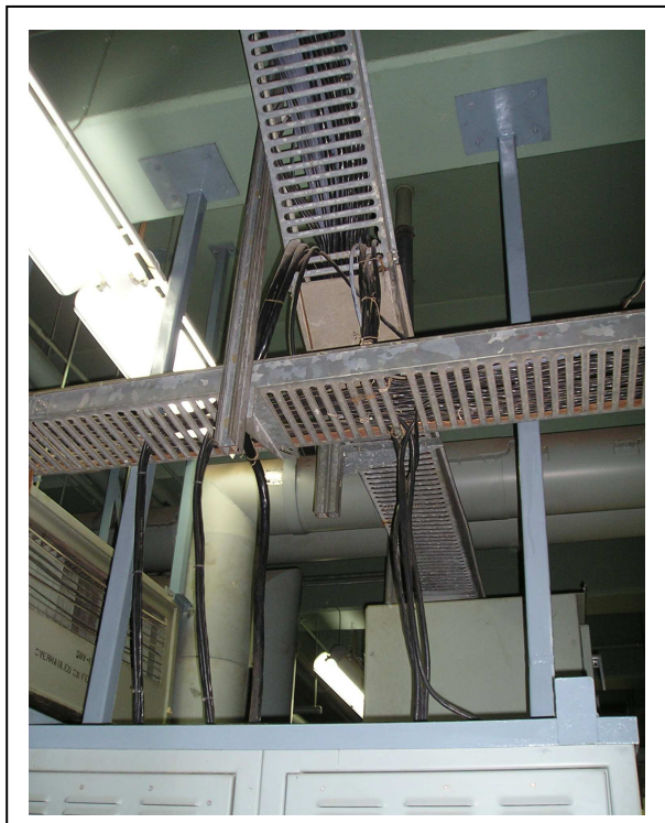
變流器盤 (INVERTER PANELS) 利用錨栓固定
