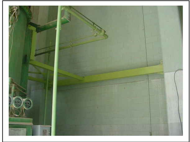
主變壓器 (MAIN TRANSFORMER) 增加支撐
