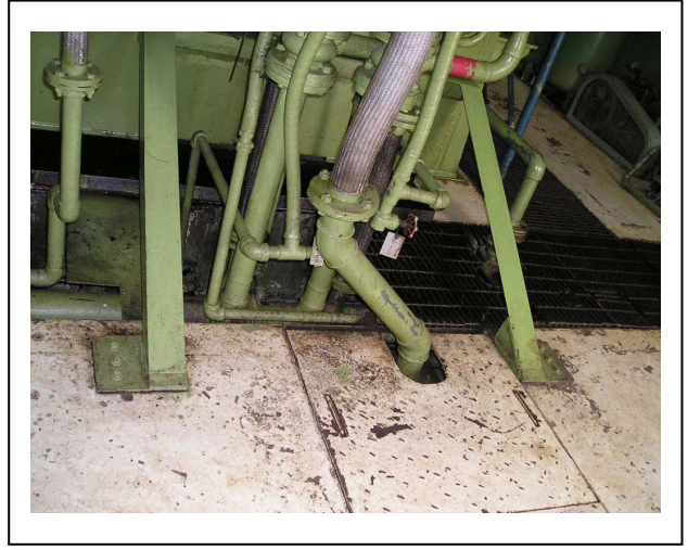
一號及二號柴油機移動限制 (LIMIT STOPS)
