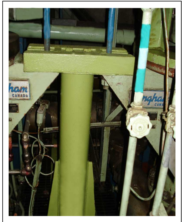
MH 泵增加支撐
