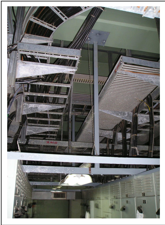
馬達控制中心 (MCC) 加裝固定器
