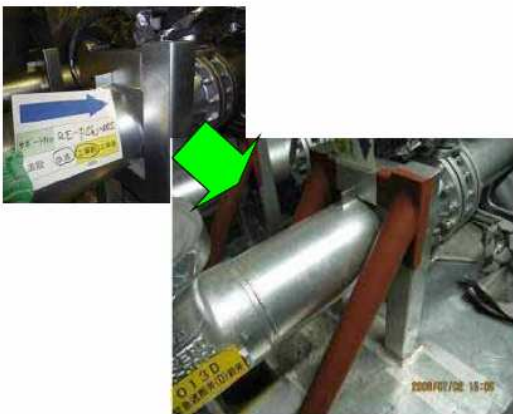
改變強化支撐方式 以加強結構
