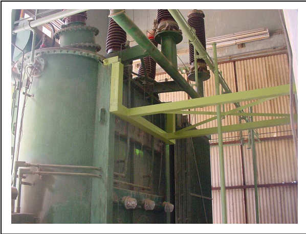
主變壓器 (MAIN TRANSFORMER) 增加支撐
