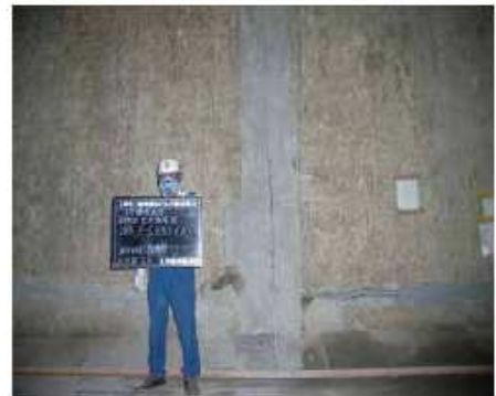
修復後海水排水渠道內部
