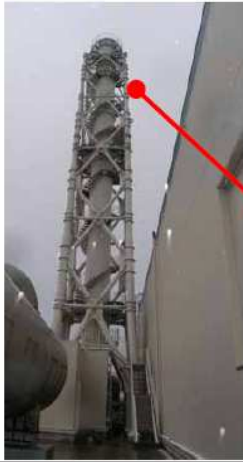
建構主排氣煙囪 新增支撐結構
