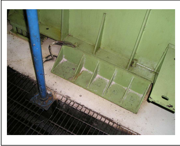
一號及二號柴油機移動限制 (LIMIT STOPS)
