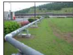
消防系統管路改為在地面上的明管
