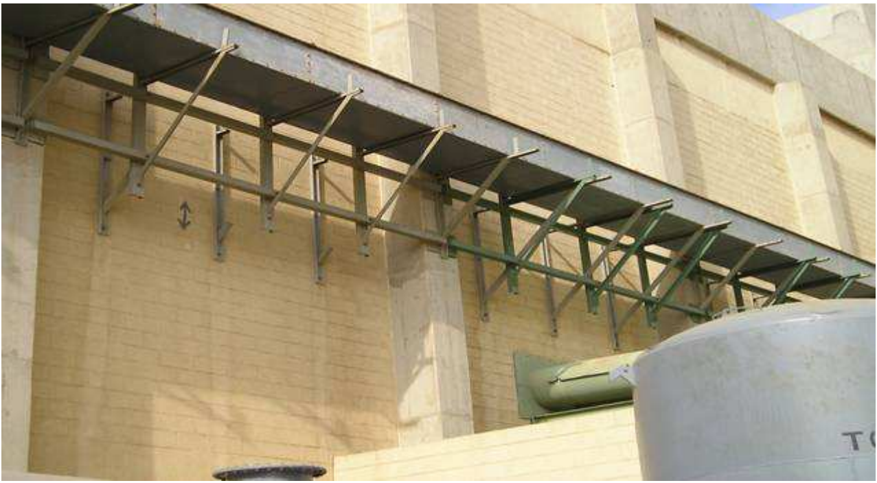
3 號柴油機匯流排導管 (BUS DUCT) 支撐位置從廠房砌牆移至由 RCC 樑柱
