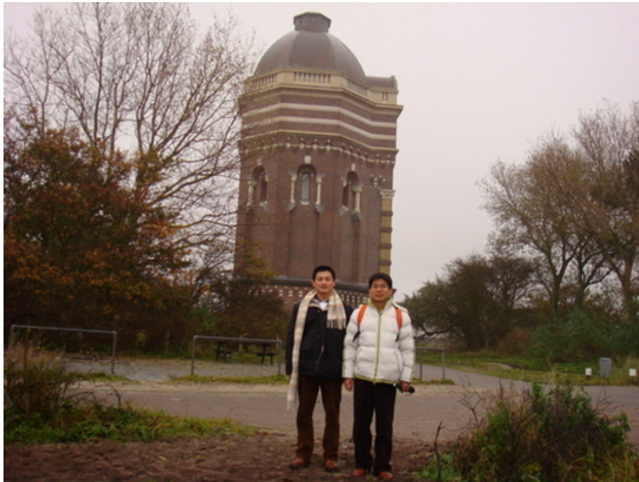
相片 2.3.6-3DZH 供水公司位於 Scheveningen 之 pumping station
