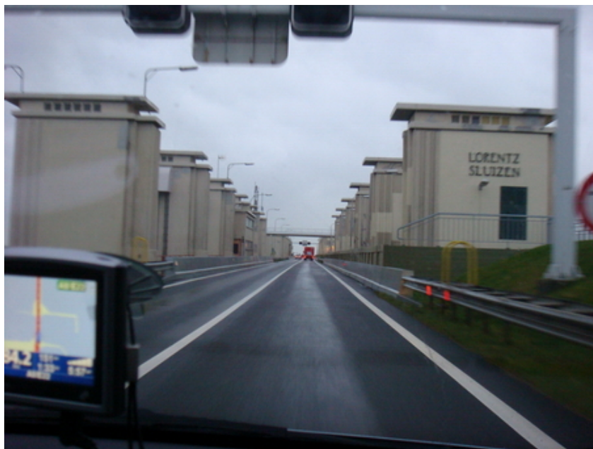
相片 2.3.8-9 羅倫茲水閘(Lorentz Sluizen)
