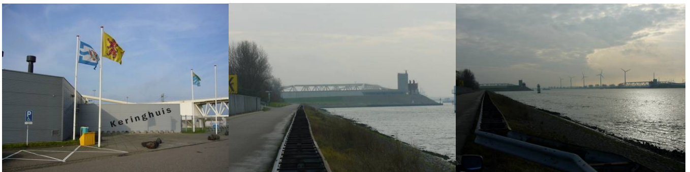
相片 2.3.7-3 位於馬仕朗阻浪閘旁邊的資訊中心 Keringhuis，中及右圖遠處可看到兩扇巨大的阻浪閘門停臥於河的兩岸待命
