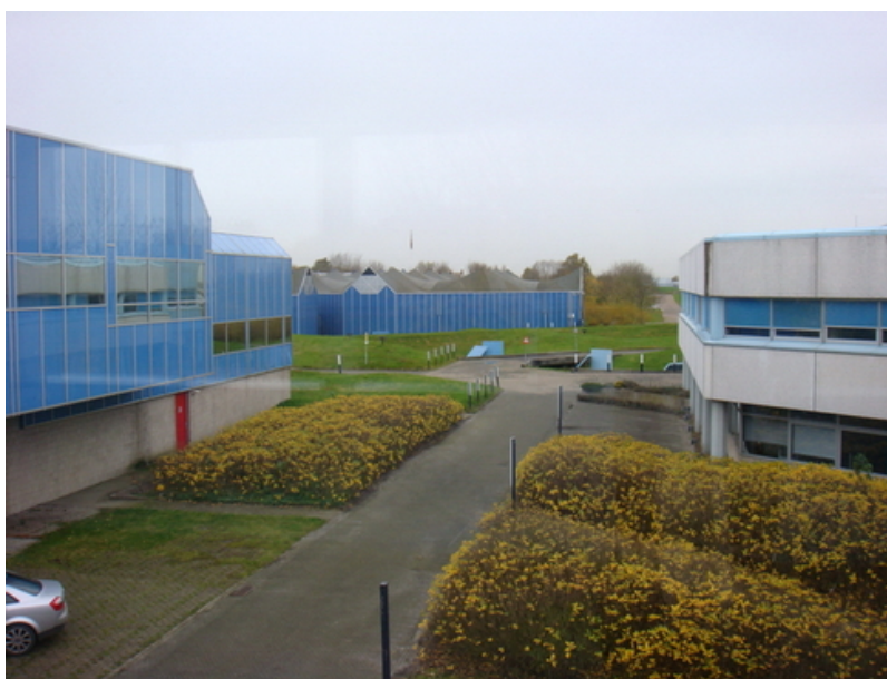
相片 2.3.8-3 PWN 水公司位於 Andijk 之淨水場區
