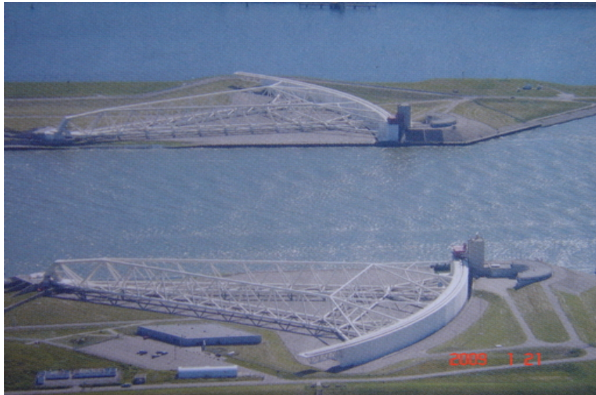
相片 2.3.7-2 馬仕朗阻浪閘有別於傳統的形式，實際上是兩扇閘門，各置於水道之兩岸，此兩扇門全開，船隻可以自由進出；兩扇門全關，可阻擋來自北海的大潮。相片中兩扇閘門正存放在兩岸長 210 公尺之船塢中。
