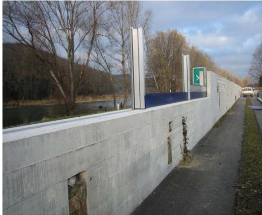
圖 2.26 制水板安裝情形
