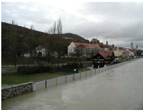
圖 3.1 多瑙河岸制水板擋水情形
