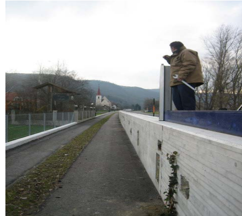
圖 2.27 制水板安裝情形
