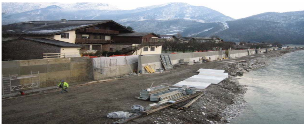
圖 3.7 凹凹凸凸的防洪牆別豎一格
