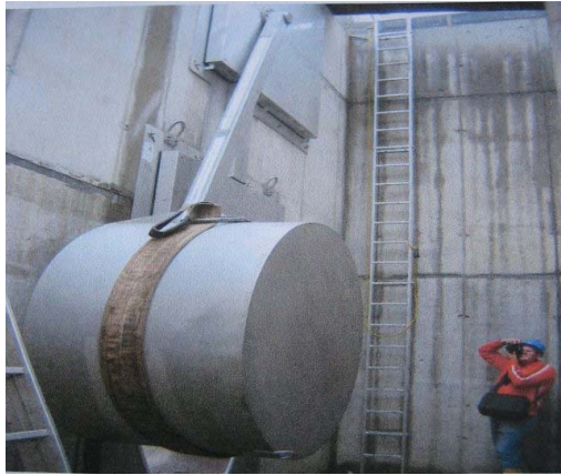
圖 2.21 安裝完成之定流量器
