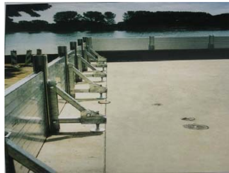
圖 2.14 制水板安裝情形
