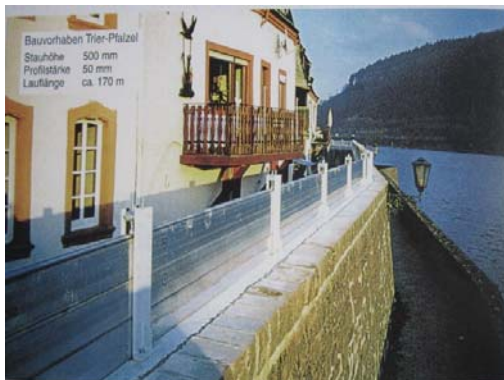
圖 2.16 圍牆上加裝制水板保護古蹟
