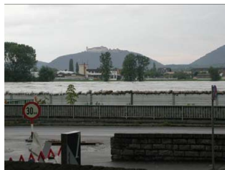
圖 3.2 多瑙河岸制水板擋水情形
