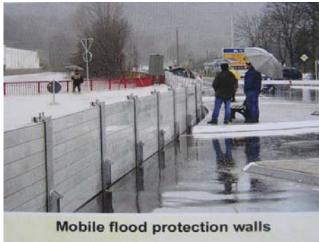
圖 2.13 制水板使用情形
