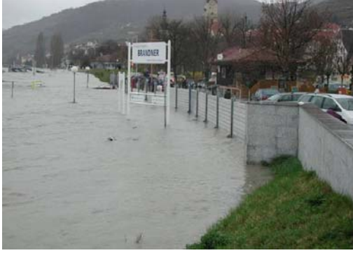
圖 2.31 制水板擋水情形
