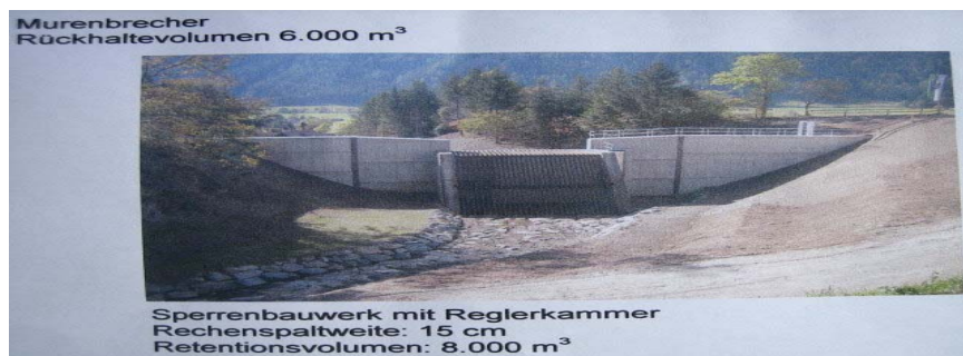
圖 2.20 定流量器實際安裝圖
