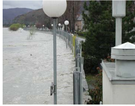
圖 2.32 制水板擋水情形
