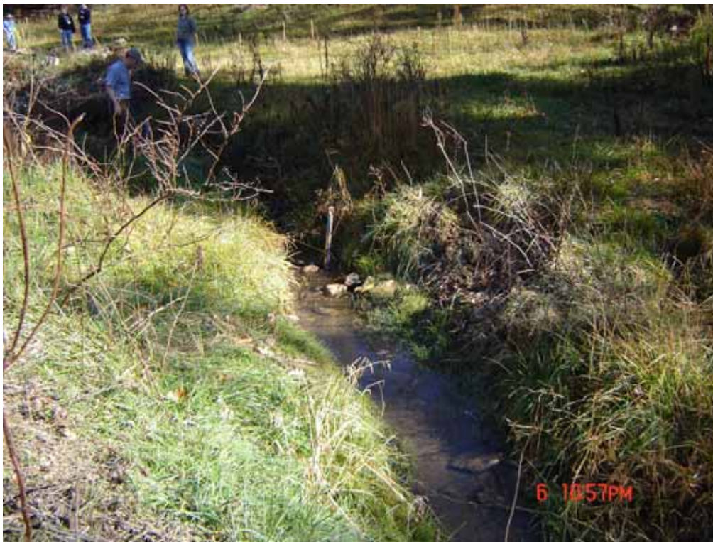
照片 03 Morgan Creek 未整治前現況
