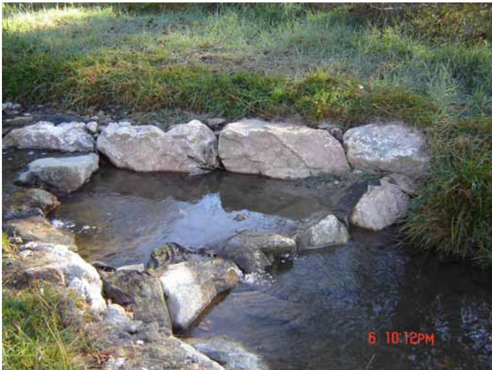
照片 06 Morgan Creek 採取石塊營造淺瀨
