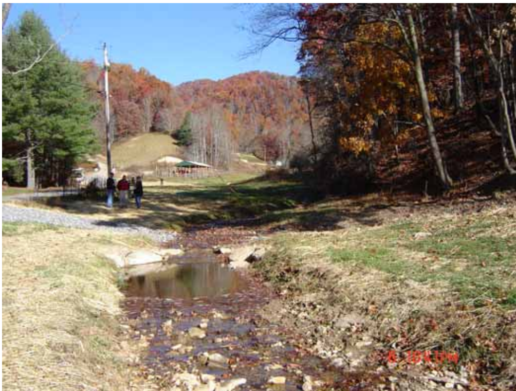
照片 04 Morgan Creek 通水斷面加大
