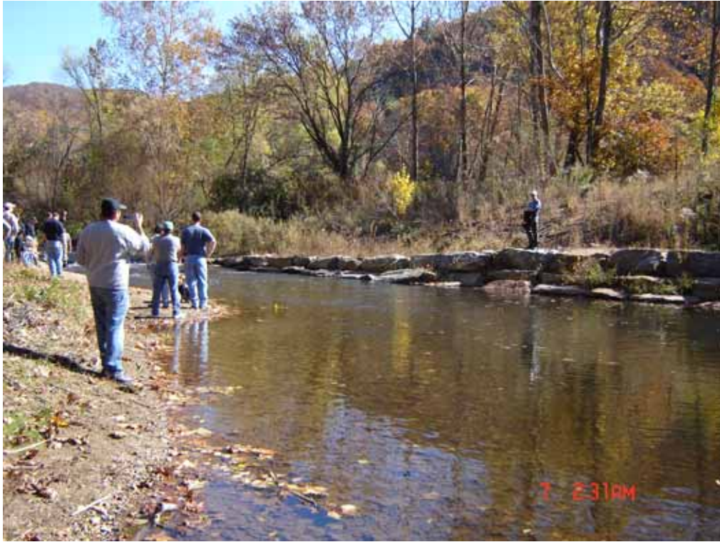
照片 13 Swannanoa River 採取巨石工保護河岸
