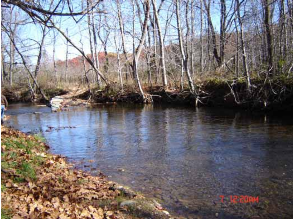
照片 10 Richland Creek 採巨石排列之挑流丁壩工
