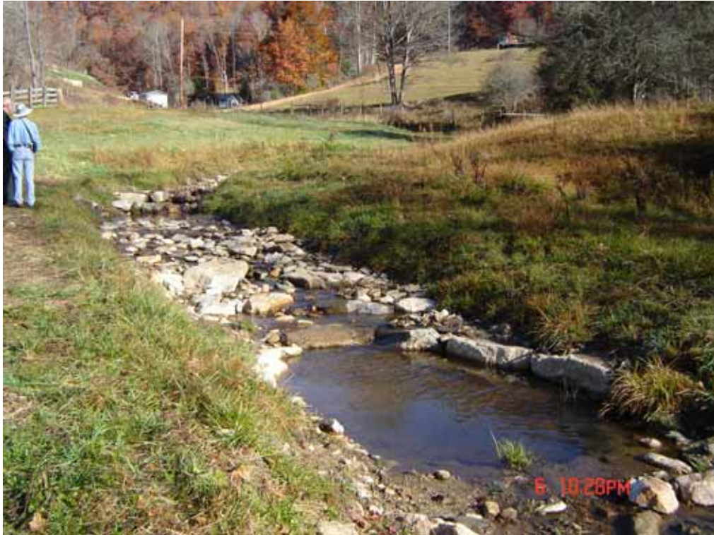
照片 05 Morgan Creek 採取石塊營造淺瀨
