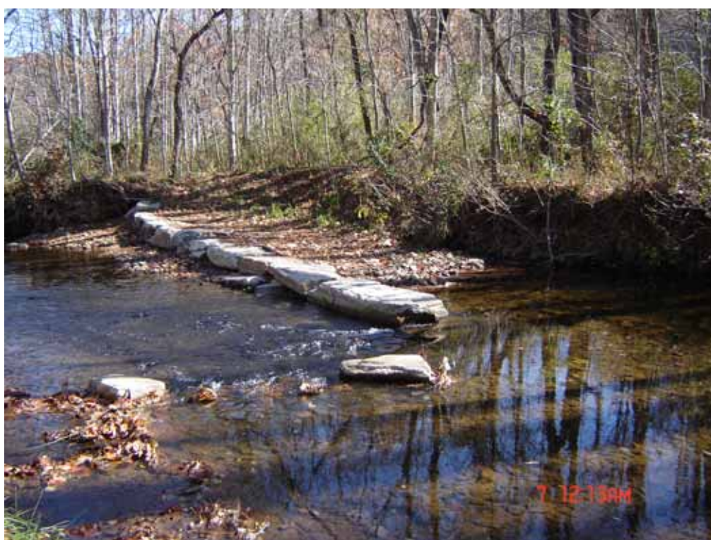
照片 09 Richland Creek 採巨石排列之挑流丁壩工
