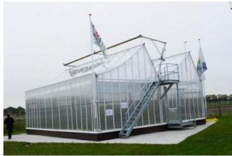
照片 26、可隨日光旋轉之溫室以儲存較多熱能，減少能源損耗。
