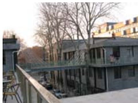
建物二樓之間架鋼橋以利往來聯繫
