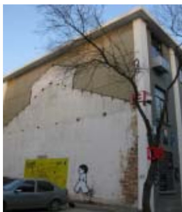
保留的與拆掉的建物痕跡
