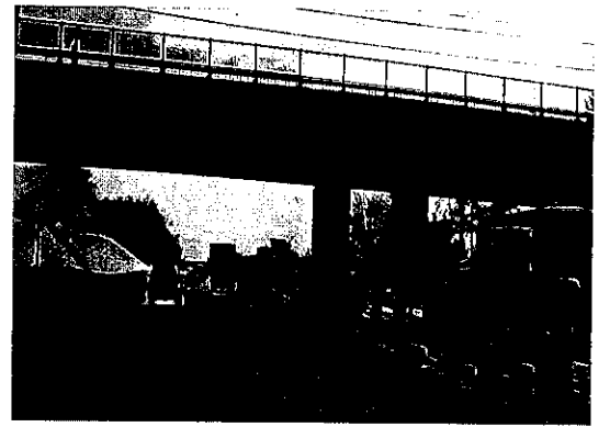
二跨連續預力梁跨越橋(一)
