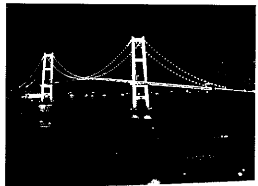
夜間景觀照明
