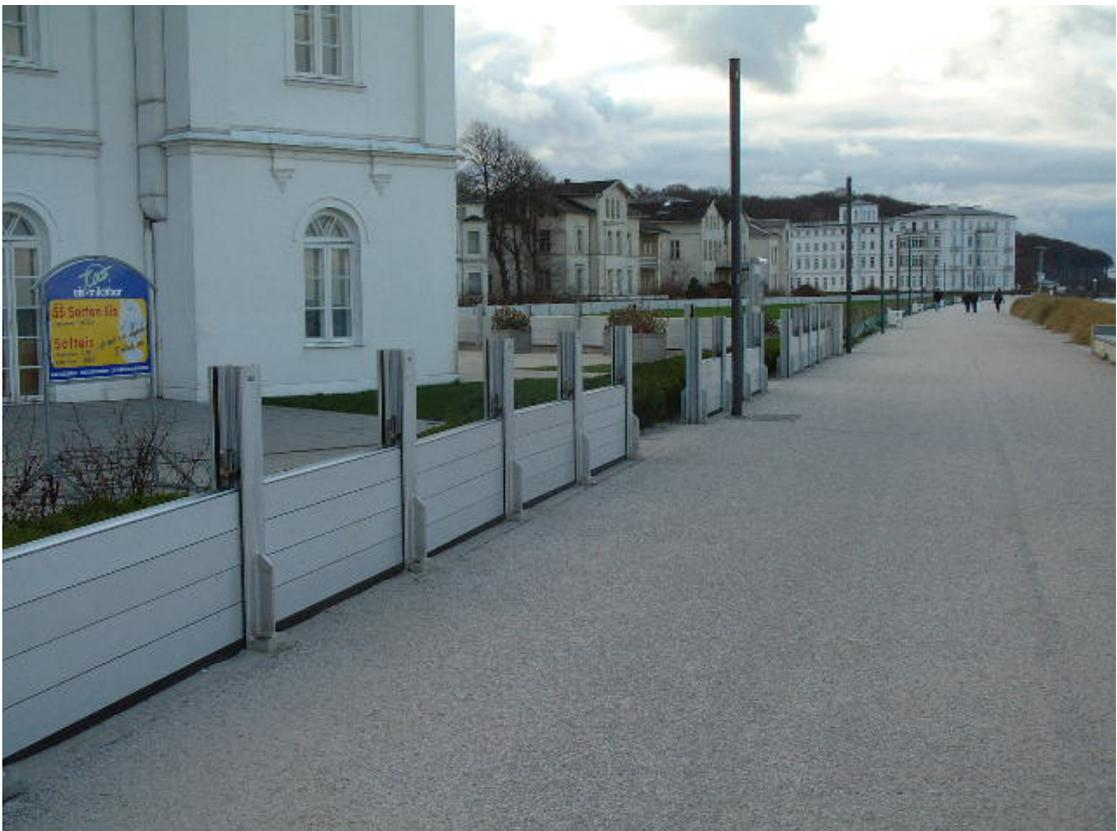
圖 6-6 羅斯托克北邊海岸可拆式擋水設施
