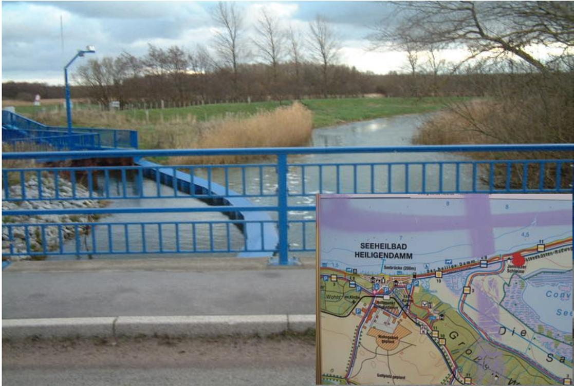
圖 6-9 羅斯托克北邊海岸取排水渠道分離及取水閘門設施
