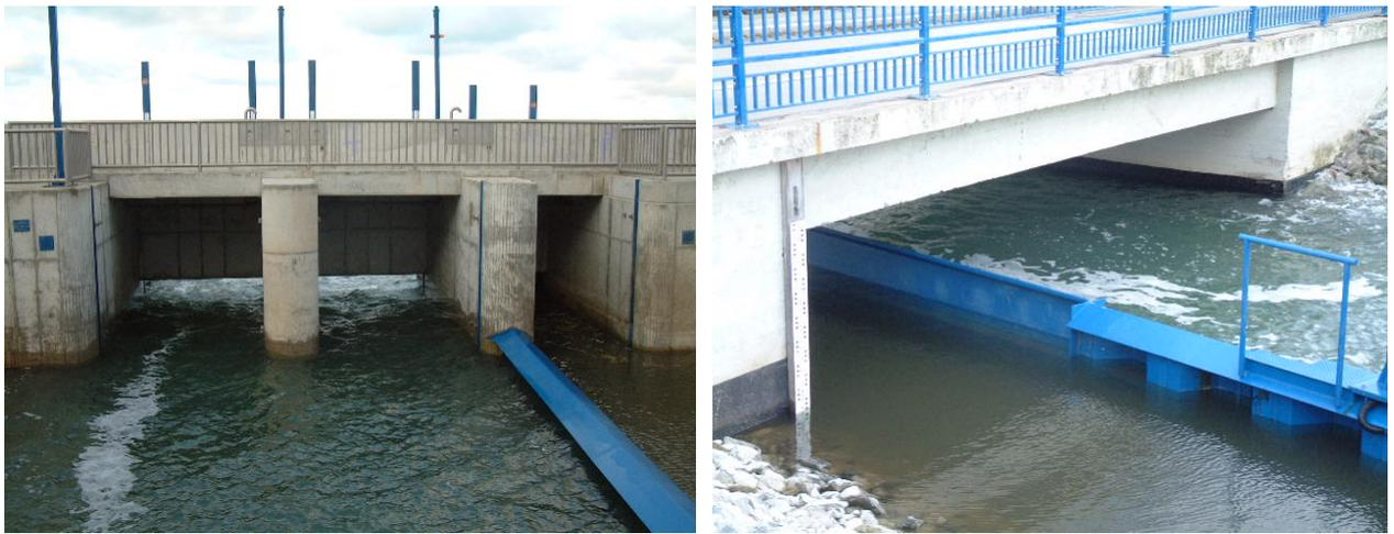
圖 6-8 羅斯托克北邊海岸海堤內側取排水分離設施
