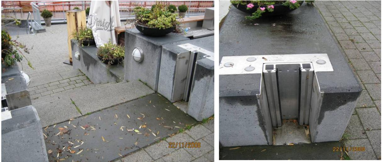
圖 5-11 科隆萊茵河岸臨河面民眾裝設可拆式擋水設施框架
