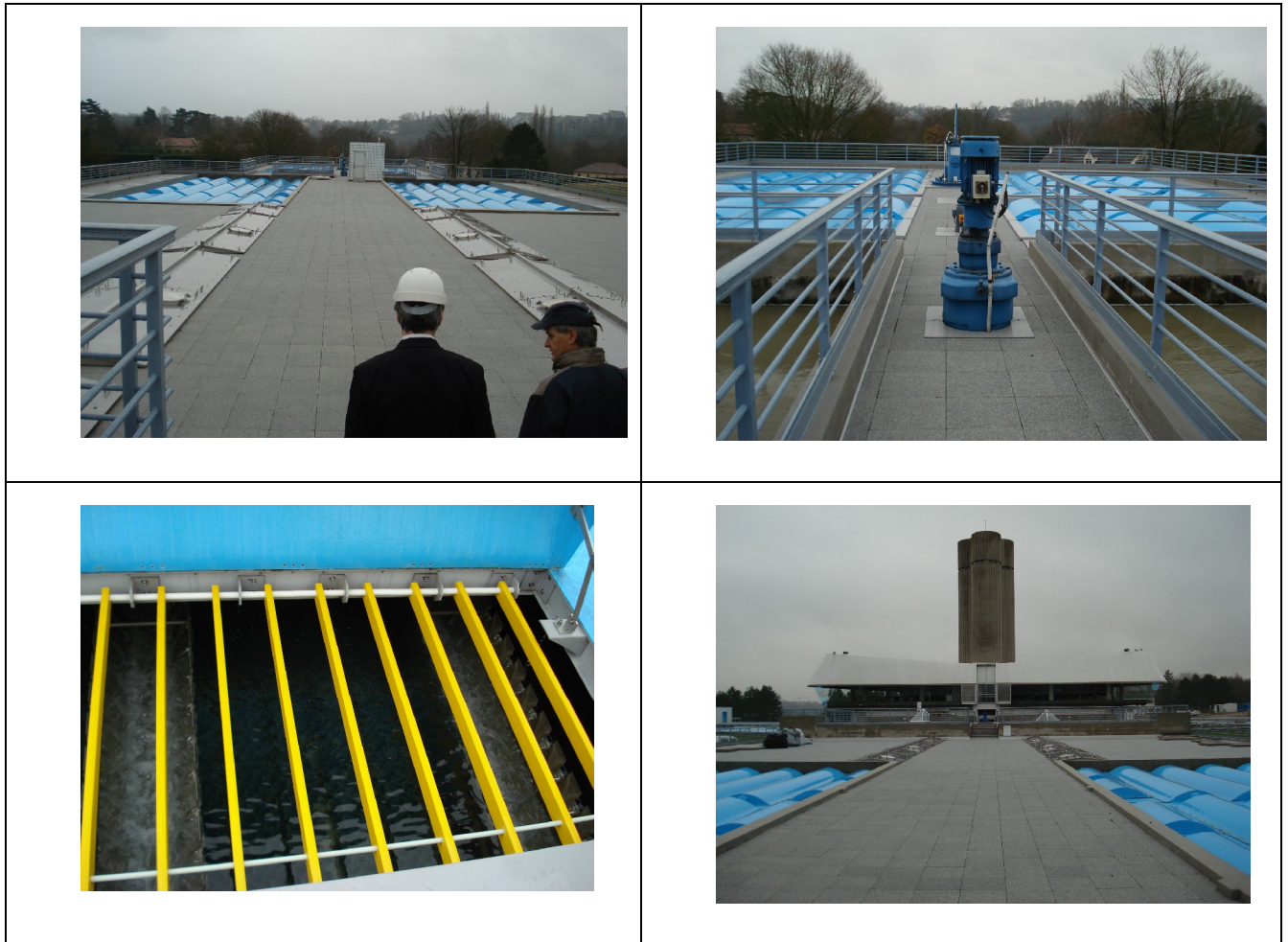
圖 34 Morsang-sur-Seine 高級淨水處理場三期沉澱池及快濾池地上全景 (藍色部份為遮蓋兼具抗風雪及防止藻類滋生功能)
