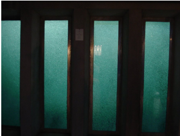
圖 36 Morsang-sur-Seine 高級淨水處理場臭氧機操作及臭氧氣泡產生情形
