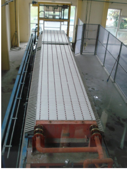
圖 37 Morsang-sur-Seine 高級淨水處理場壓濾式脫水機及泥餅產生情形
