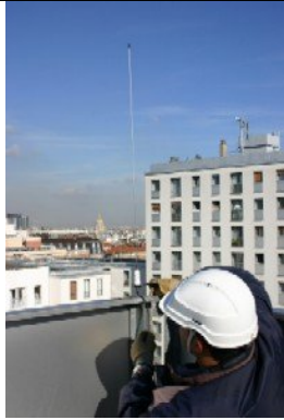
(1) AVIZ'EAU®系統 - 以 VHF 天線接收用水資訊傳至手持機接收
