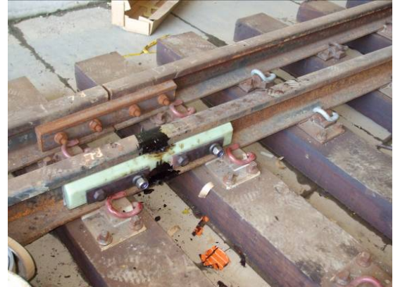
圖59 序8.安裝完成接頭再塗漆
