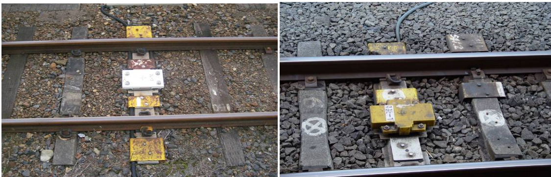
圖23 ATS-P地上感應器及電纜防護
