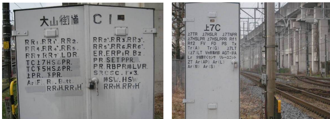
圖29 控制箱外表以代號標記設備機能
