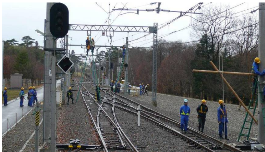
圖12 實習場電車線架線實習情況
