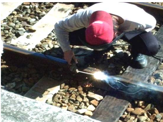
圖 62 雙重連軌線焊接作業
