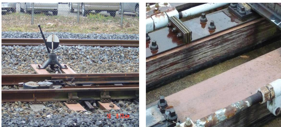
圖30 JR在來線合成枕木設置情形
