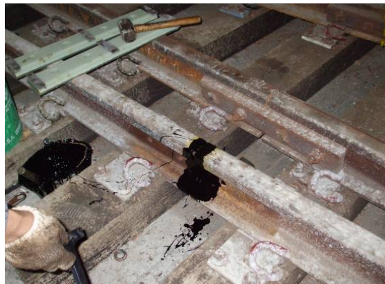
圖53 序2.鋼軌底、腹塗上安打底漆
