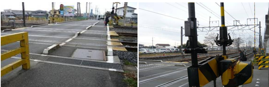
圖32 人車分離的平交道與緩衝防撞遮斷機
