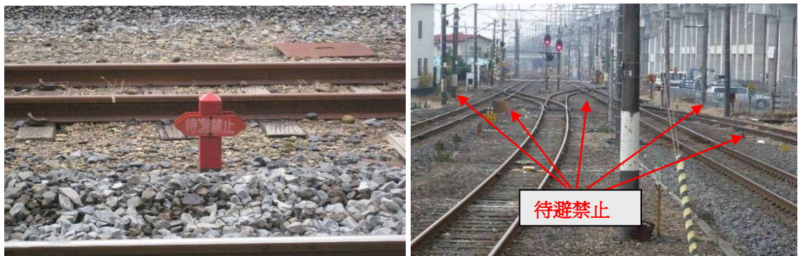
圖33 路線作業安全警示標誌
