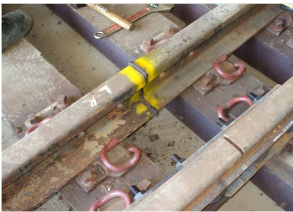
圖52 序1.清除鐵屑鐵鏽放入絕緣片
