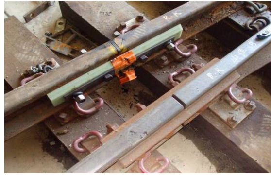
圖57 序6.均衡上緊4支螺栓
