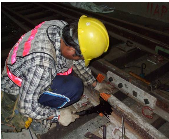
圖54 序3.貼上布條再塗上安打底漆
