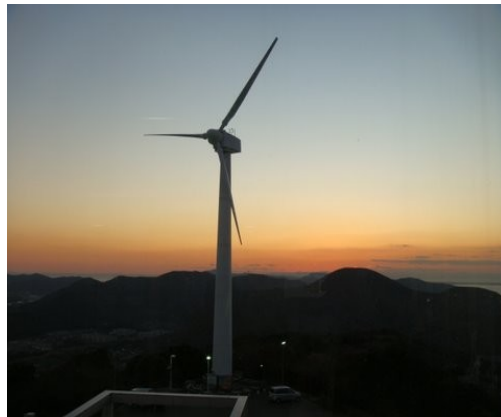
圖 3-1：葺王山展望台風力發電所
