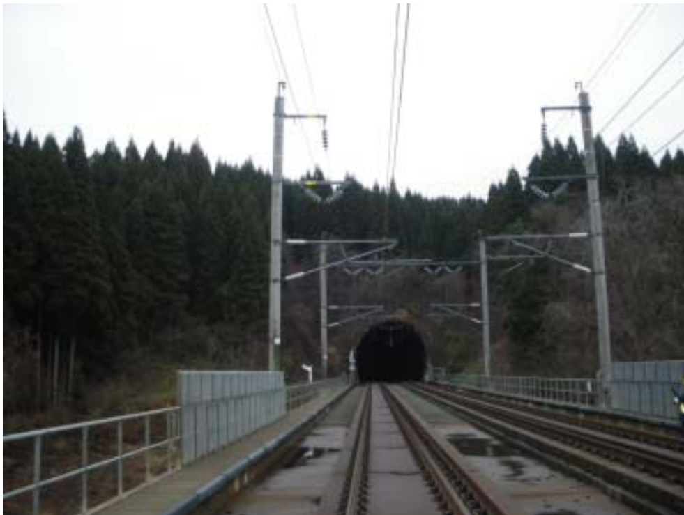
青函隧道口三軌完成
