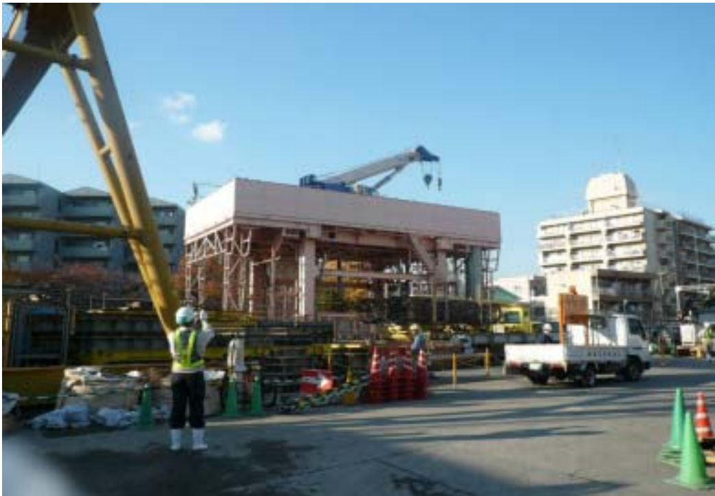
鐵路高架工法施工作業車
