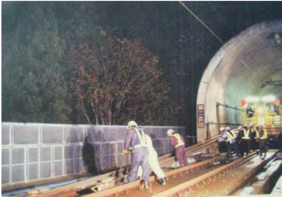
軌道共構現場施工
