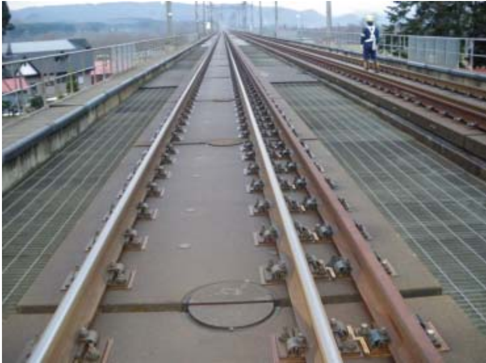
路段三軌完成
