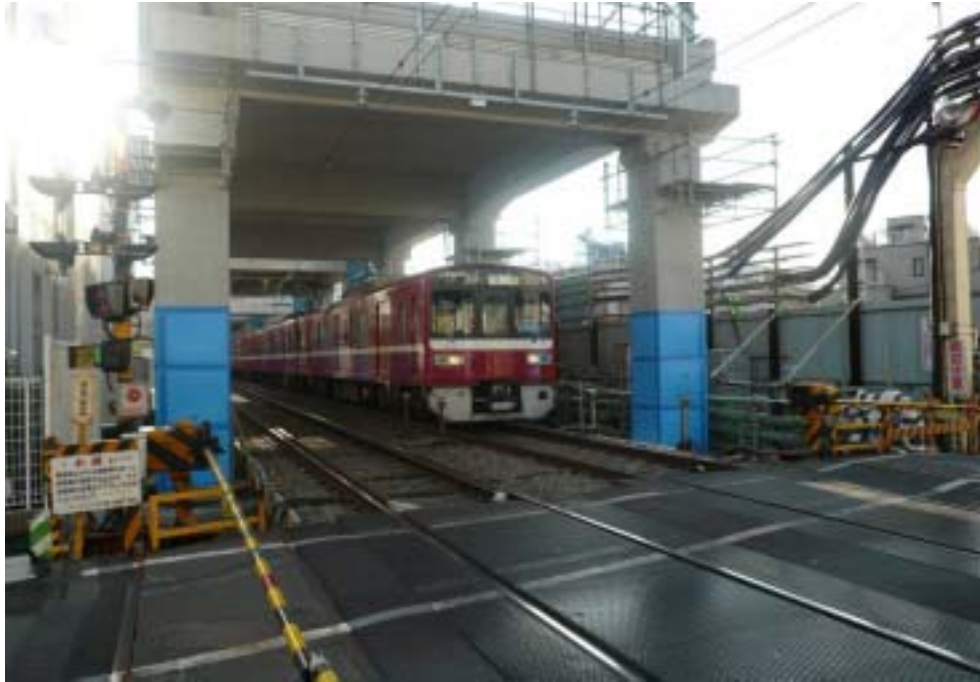
鐵路營運及高架工法施工
