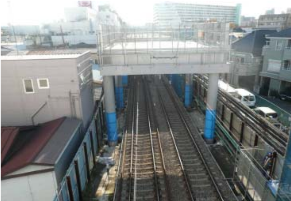
鐵路營運及高架工法施工
