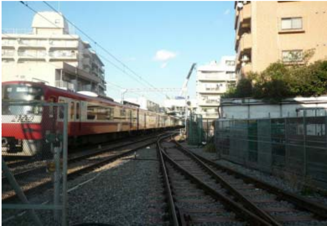
鐵路營運及高架工法施工
