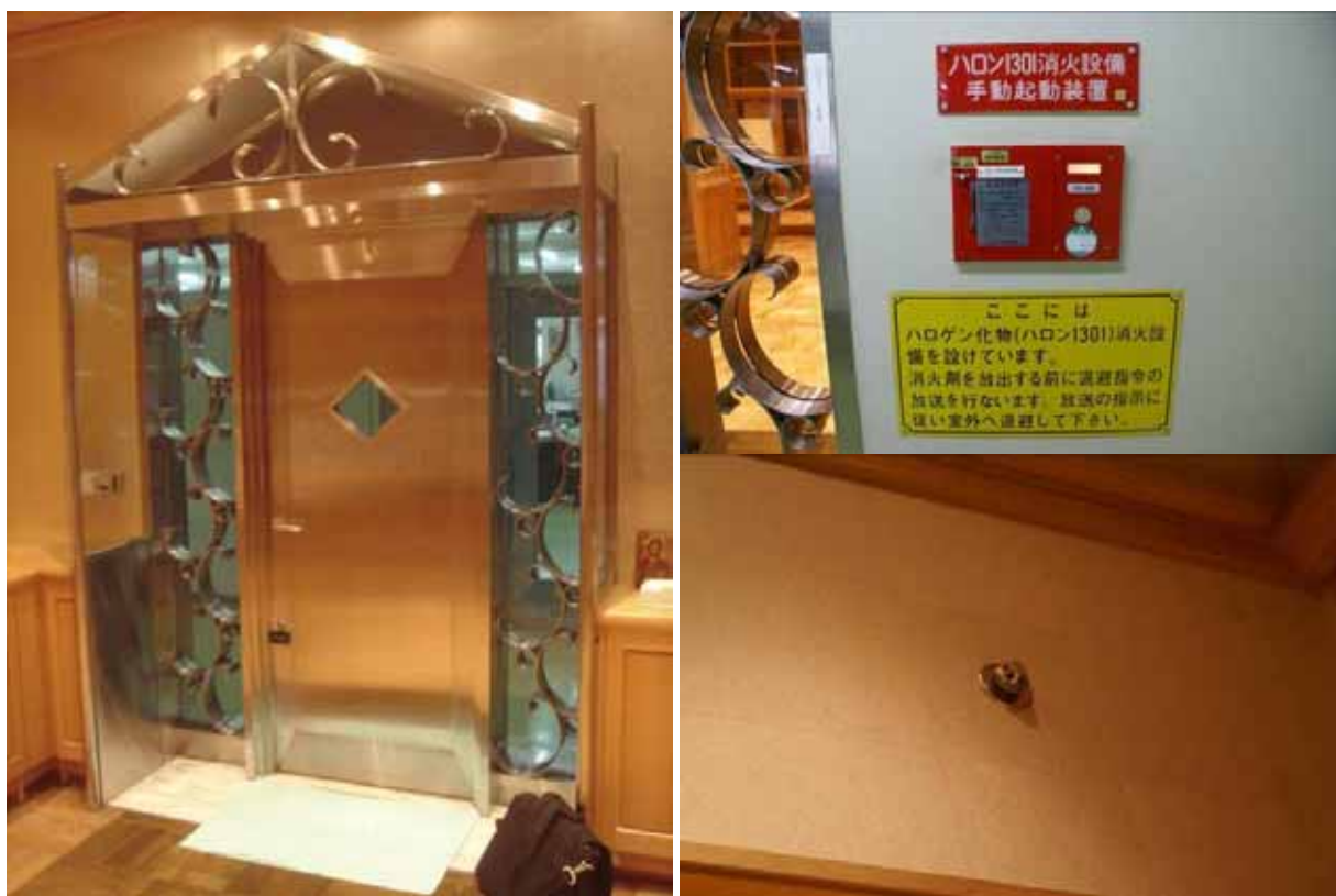
金澤大學典藏庫房鐵門內側（左）、海龍 1301 型消防設施（右上）、對紙質文物較少損害的海龍自動噴出口（右下）
