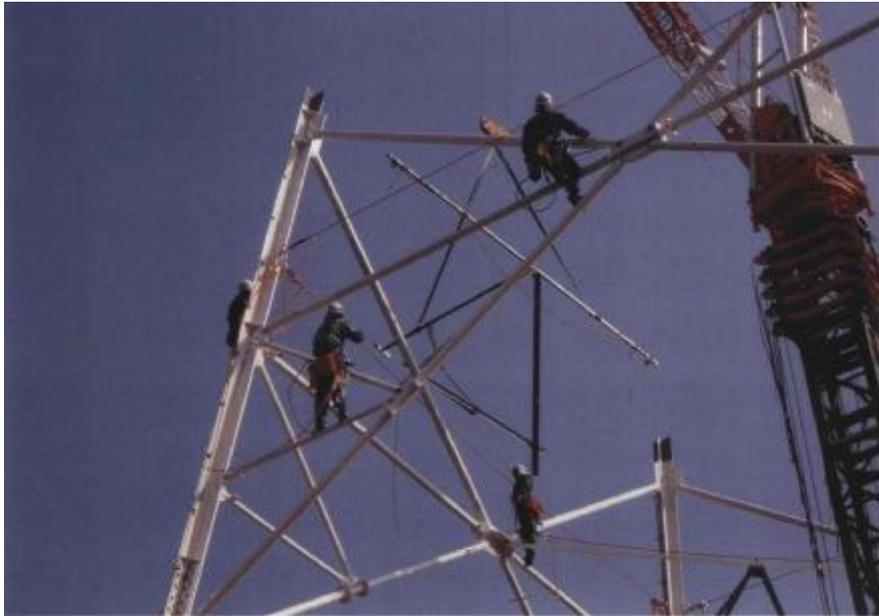
圖 13 施工人員使用鍵索裝置情形
