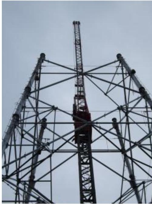
圖 12 鐵塔之吊塔式組裝圖
