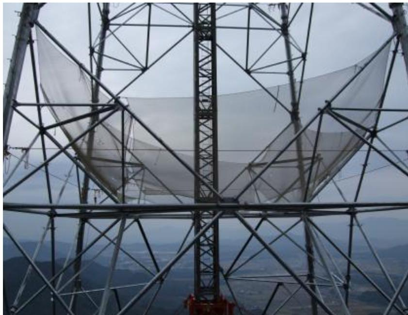
圖 14 鐵塔塔內下方架有防護網
